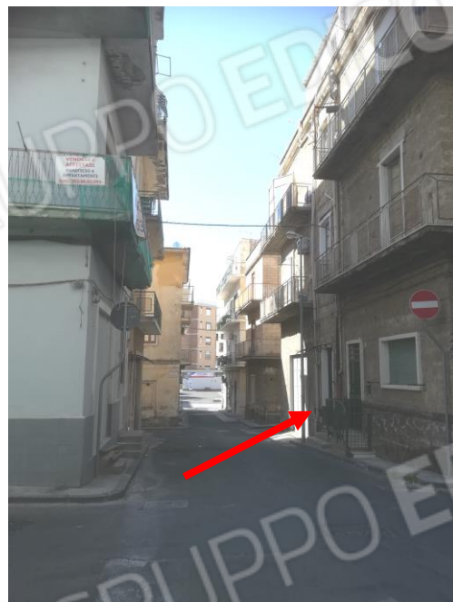
foto 2 – accesso edificio via Lisia n. 21
