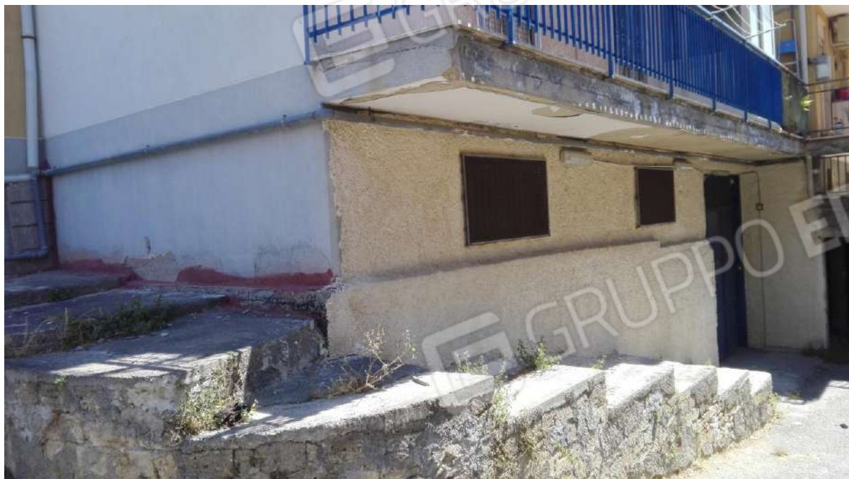
Foto 1 – Visione scivolo e ingresso lato esterno
