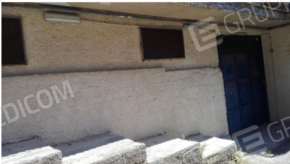
Foto 2 – Visione ingresso lato esterno
