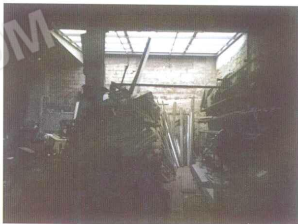
foto 3 – vista del lucernario realizzato sul lato destro in luogo del cortile
