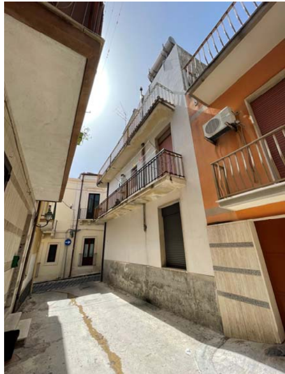
Vista del fabbricato su Via Scianna
