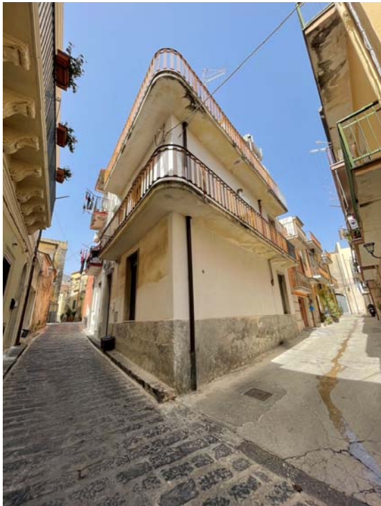
Vista del fabbricato ad angolo tra Via Vittorio Emanuele e Via Scianna
