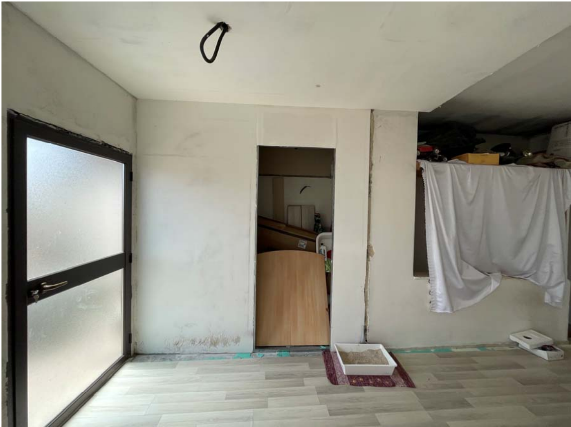
Vista del locale di sgombero con accesso al servizio igienico
