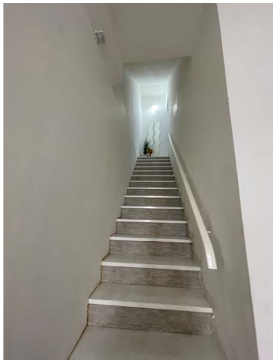
Vista del corpo scala
