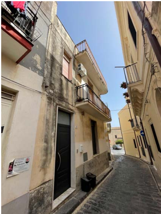
Vista del fabbricato su Via Vittorio Emanuele
