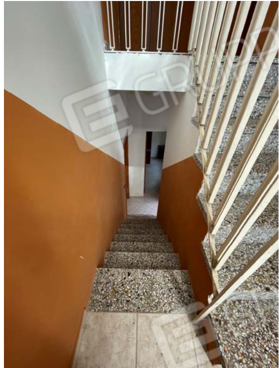
Vista della scala interna in corrispondenza dell'ingresso
