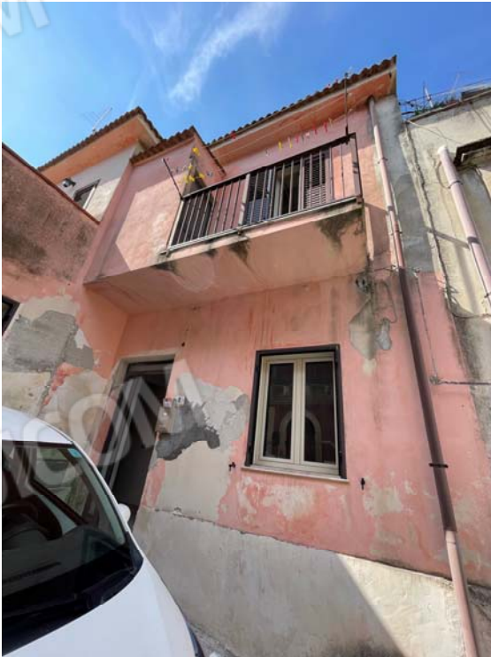
Vista esterna dell'immobile
