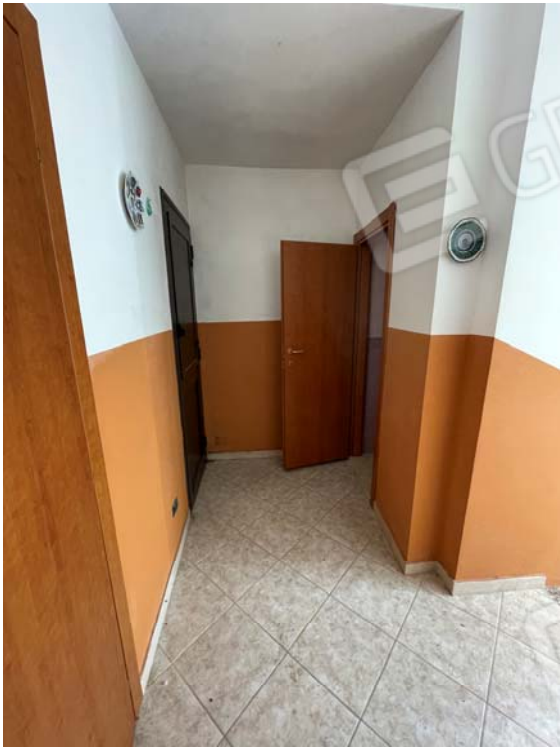
Vista del disimpegno del primo piano
