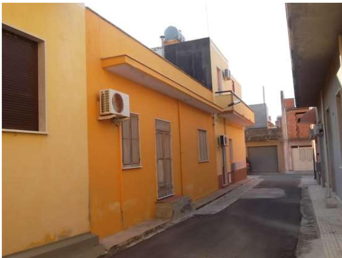
Foto 3 – Immobile “1A” - Prospetto posteriore visto da Nord-Est
