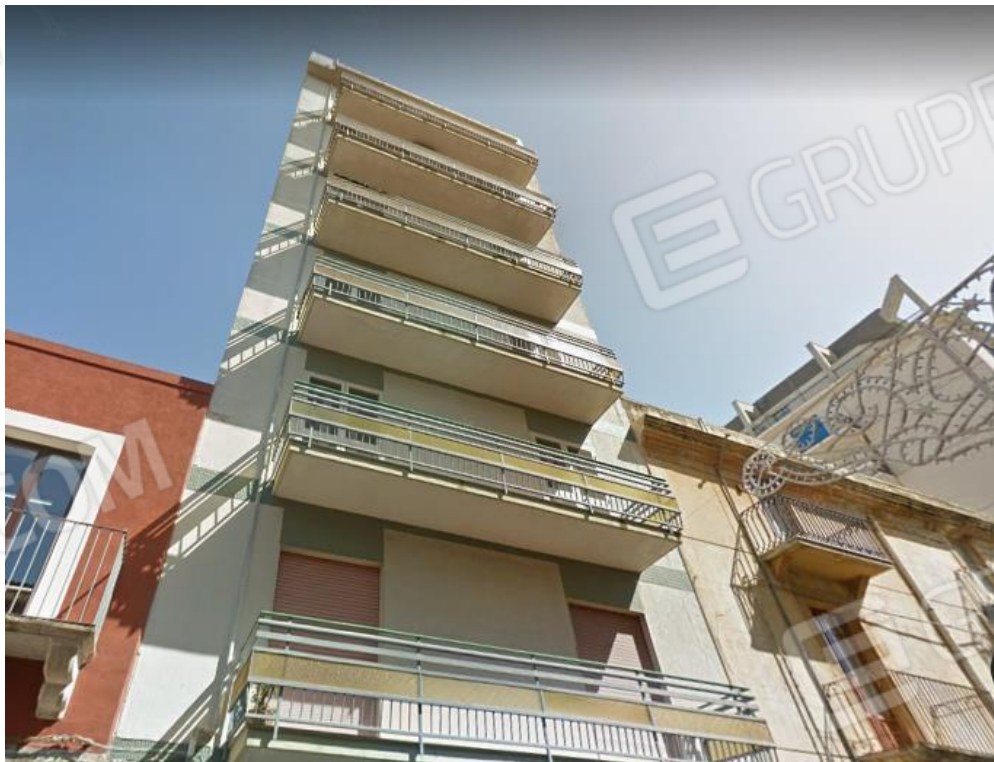
Foto 2 _vista del prospetto principale a sud
