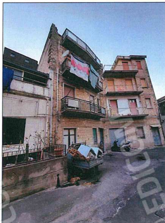
Foto 2-3 - Prospetto su Cortile Atene con ingresso dai numeri civici 14-15. L'immobile è composto da piano terra, primo, secondo e terzo piano. La facciata non è rivestita e i ballatoi necessitano di lavori di manutenzione.
