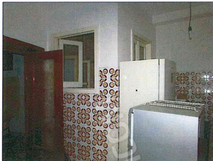
foto 10 - Dal soggiorno si accede ad un disimpegno (collegante la zona notte) in cui si trova l'affaccio nel cavedio.
