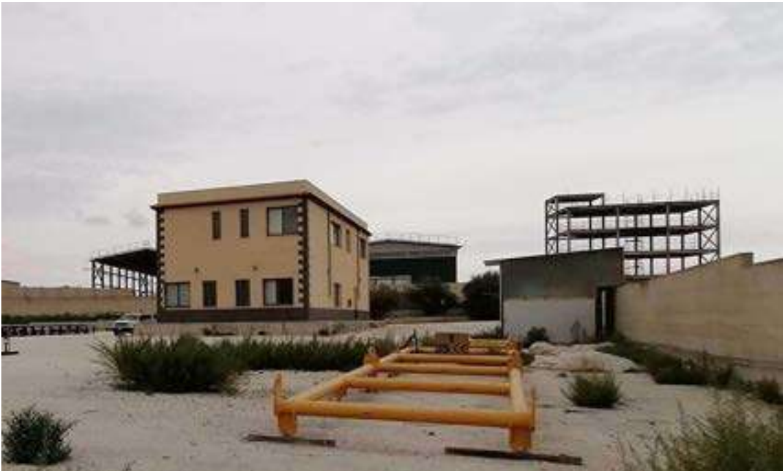
Foto 13 – Palazzina uffici e tettoia lato est
