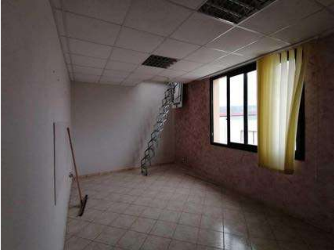
Foto 20 - Palazzina uffici p.1
