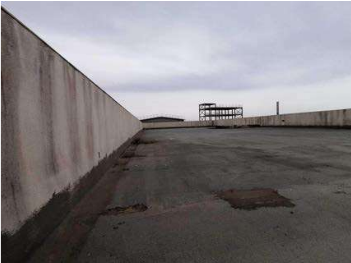
Foto 20 – Copertura palazzina uffici
