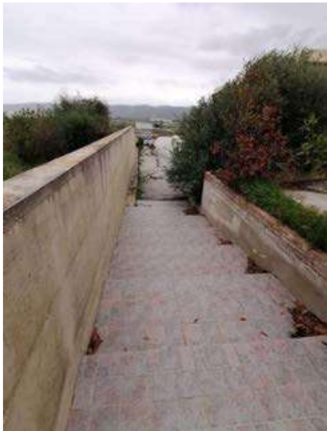
Foto 4 – Zona ingresso pedonale
