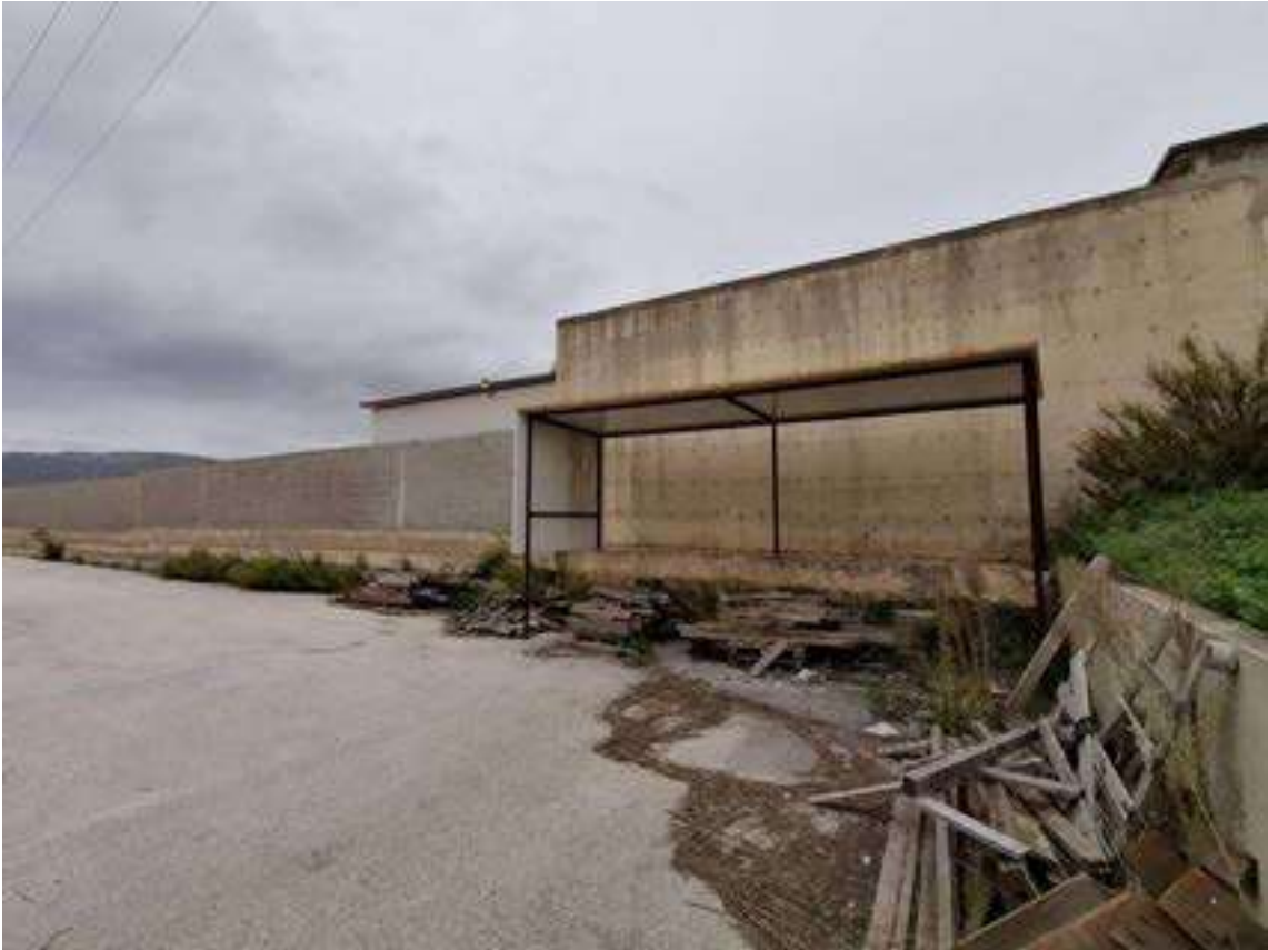
Foto 12 – Tettoia lato ovest
