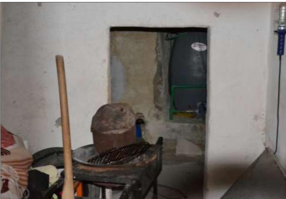
**Fot.n°4:** garage; la tramezzatura divide l'ingresso dalla parte retrostante adibita a vano tecnico; sullo sfondo a dx il serbatoio d'acqua allocato nella nicchia ricavata dall'originario vano scala di collegamento con l'abitazione soprastante.
