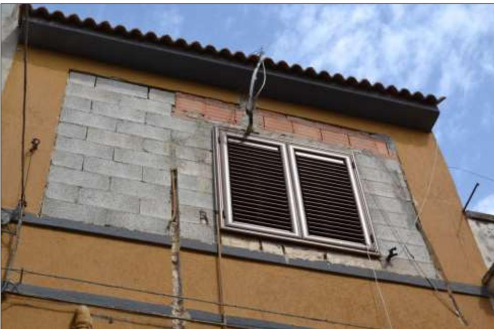
**Fot.n°4:** prospetto su Via Arco Grande, particolare del piano 1° con la muratura di tamponamento a chiusura della preesistente copertura-terrazza.
