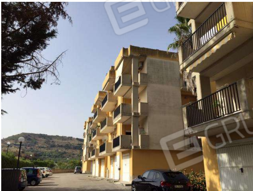
Foto 7. Prospetto su corte comune.
