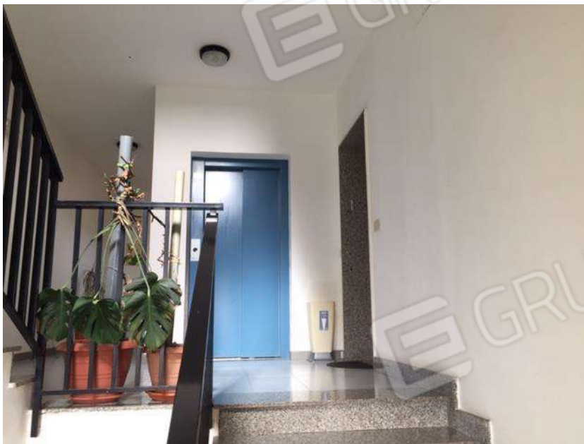
Foto 15. Vano scala condominiale.
