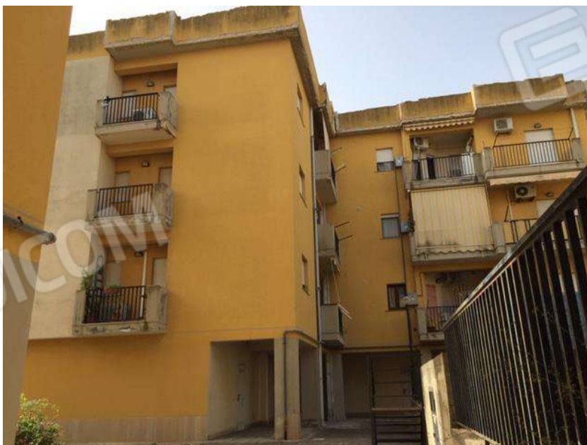
Foto 10. Prospetto su corte comune.
