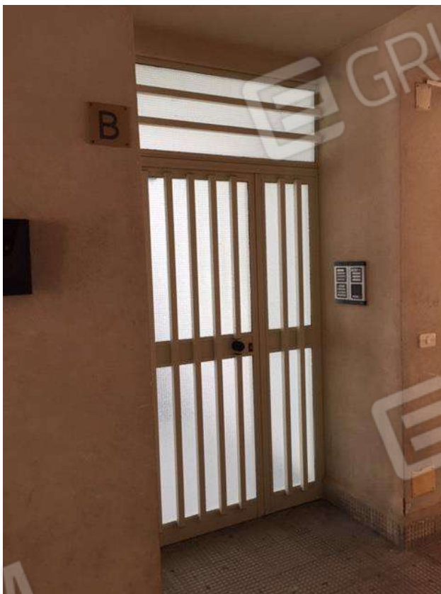
Foto 13. Portone di ingresso all'edificio scala B.
