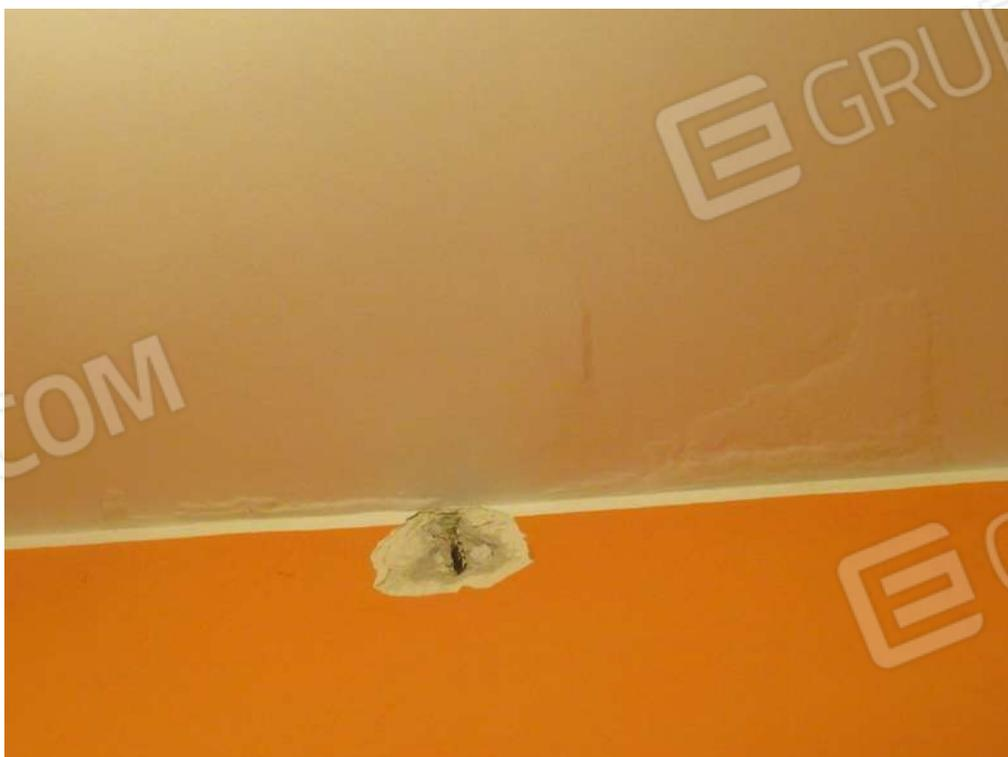
Foto 26\_Caduta intonaco su soffitto e sottostante armatura a vista
