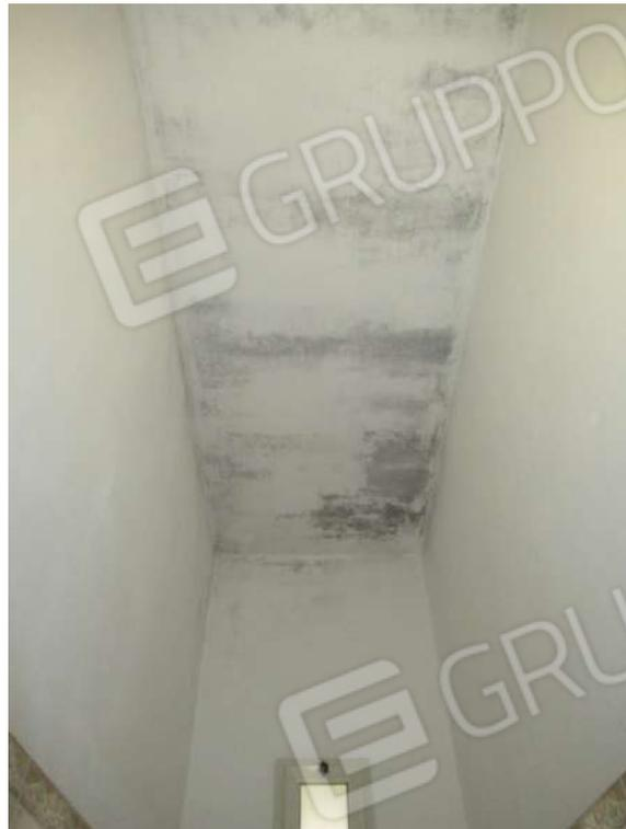
Foto 32\_ Degrado su soffitto bagno
