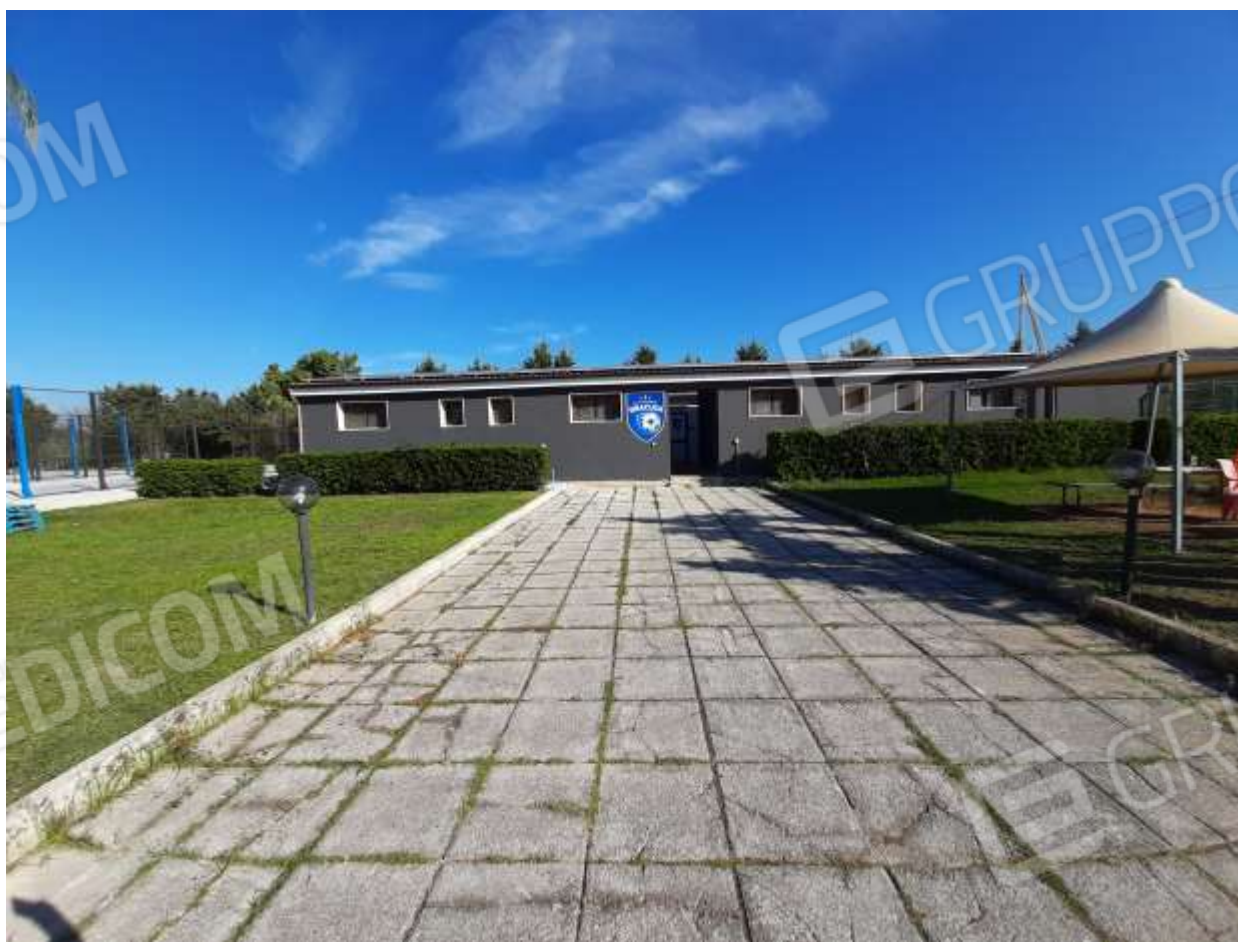
Foto n. 24-25 -26-27-28 – due fabbricati adibiti a spogliatoi al servizio dei campi da calcio
