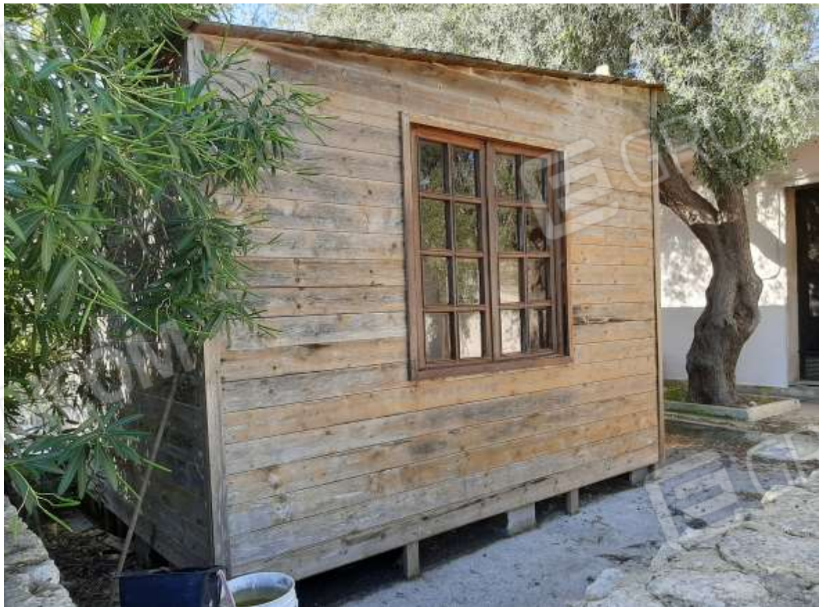
Foto n.6 – locale prefabbricato in legno uso deposito
