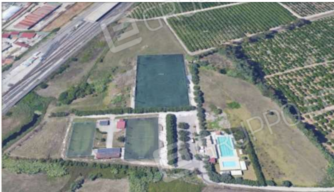
Foto n.1 – vista dall'alto dell'intero centro sportivo
