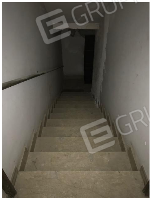
VISTA 3_ vano scala P.T.\P.1°
