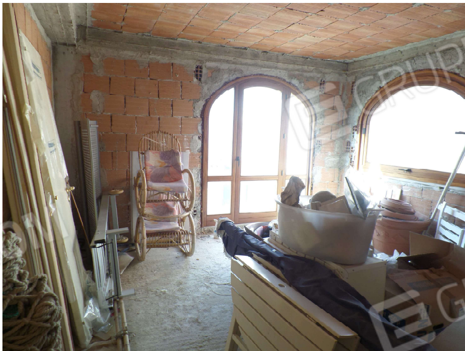
Foto n° 16. Piano 1°: Vano 4/Soggiorno/Pranzo
