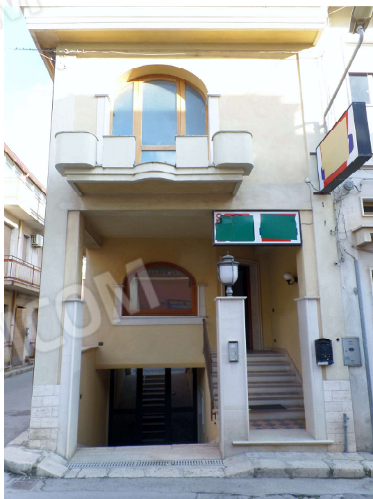
Foto n° 2. Prospetto: Via D. Alighieri n° 122
