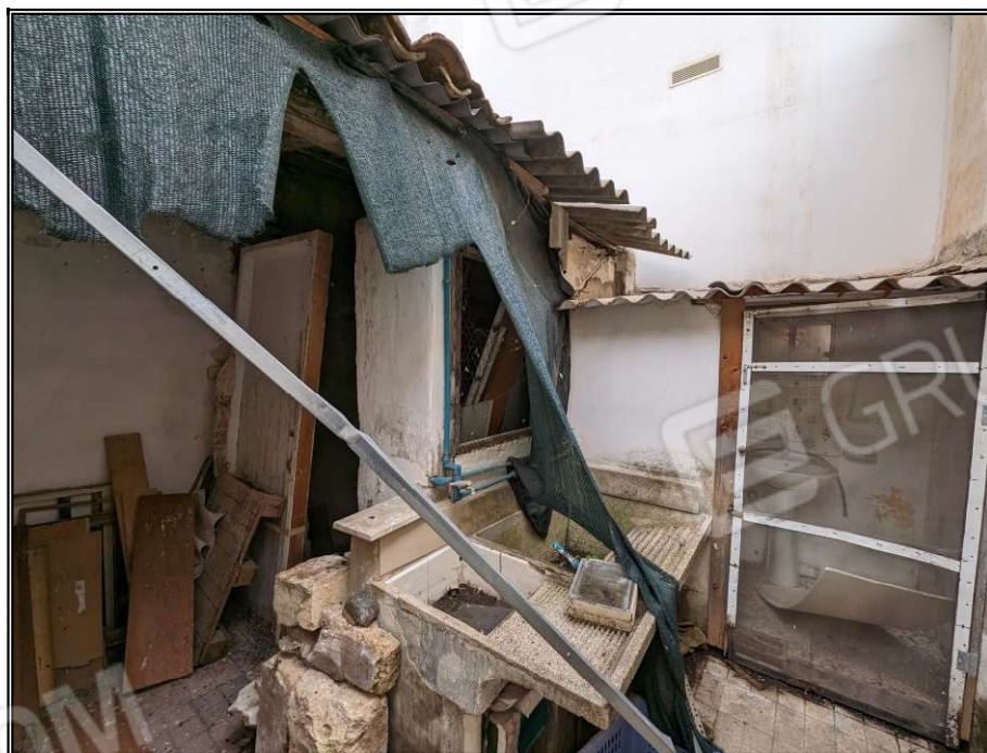
Foto n° 13 – Esterno ripostiglio, tettoia e w.c.
