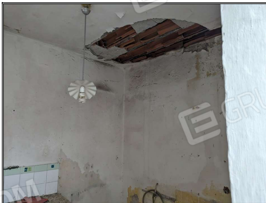
Foto n° 11 - Particolare soffitto locale forno
