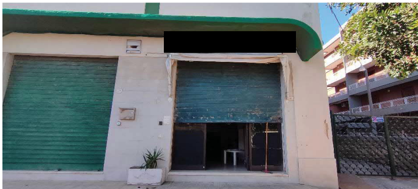
Foto 8: esterno lato via servi di maria
