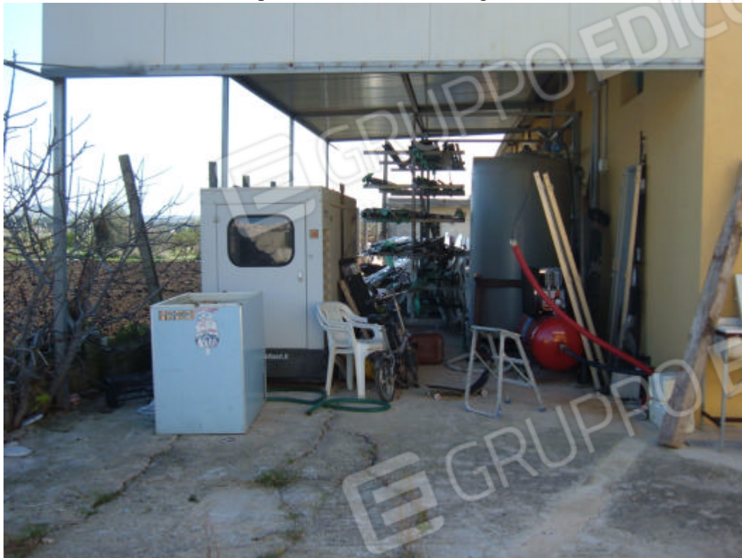
IMMOBILE B – Vista Prospetto Nord – Ovest dettaglio tettoia
