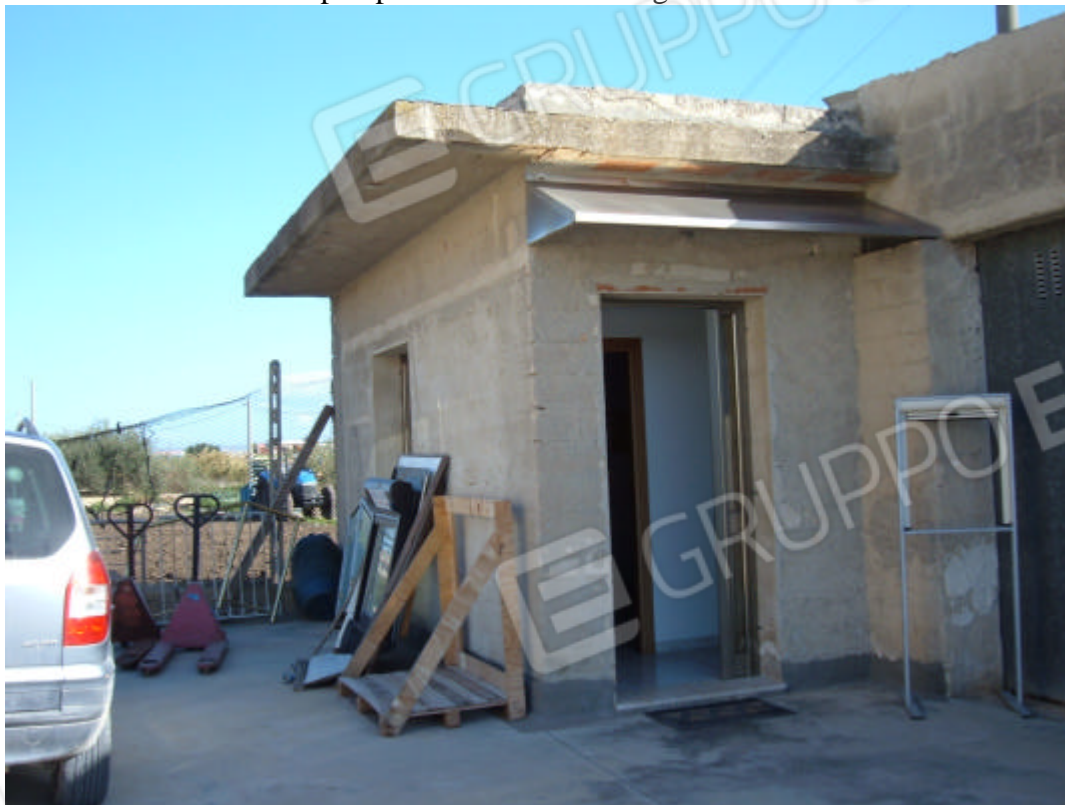
IMMOBILE A – Vista prospetto Nord – Ovest ingresso Blocco 2
