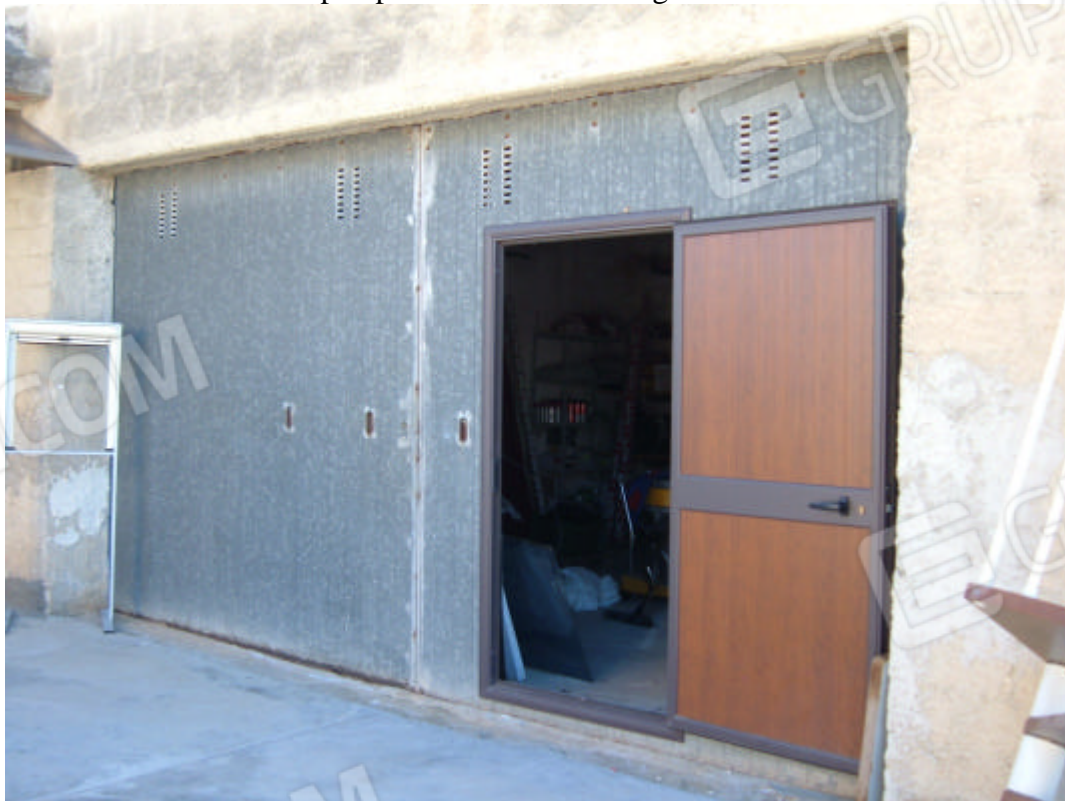
IMMOBILE A – Vista prospetto Nord – Ovest ingresso Blocco 1
