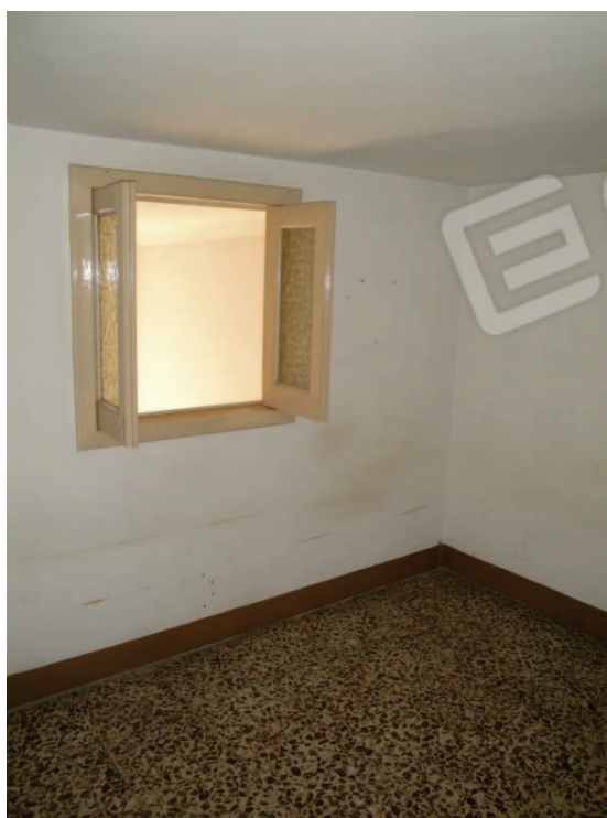
foto 6_ veduta interna della zona soppalco
