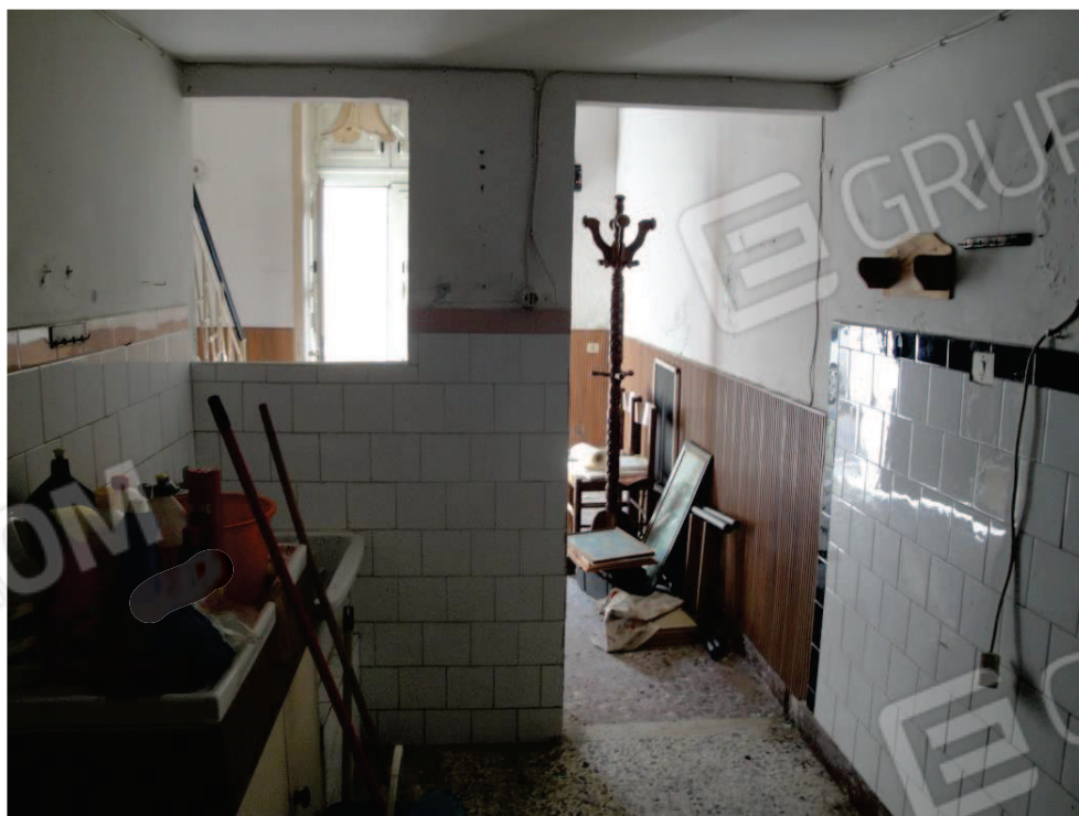
foto 4_ veduta interna della zona servizi
