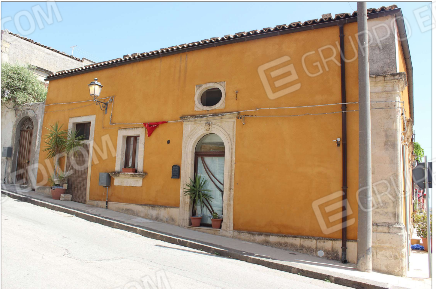
N.2 Vista da Via G. Matteotti
