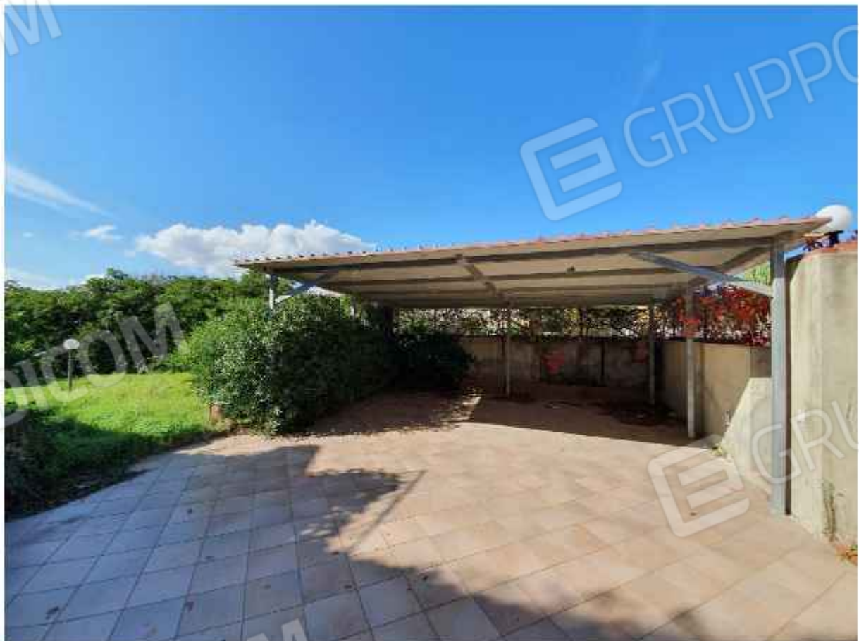
Foto 02 — Vista tettoia abusiva
