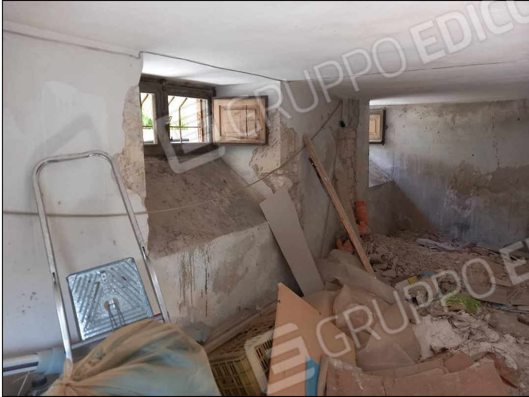
Foto 5: Vista dell'interno del locale
