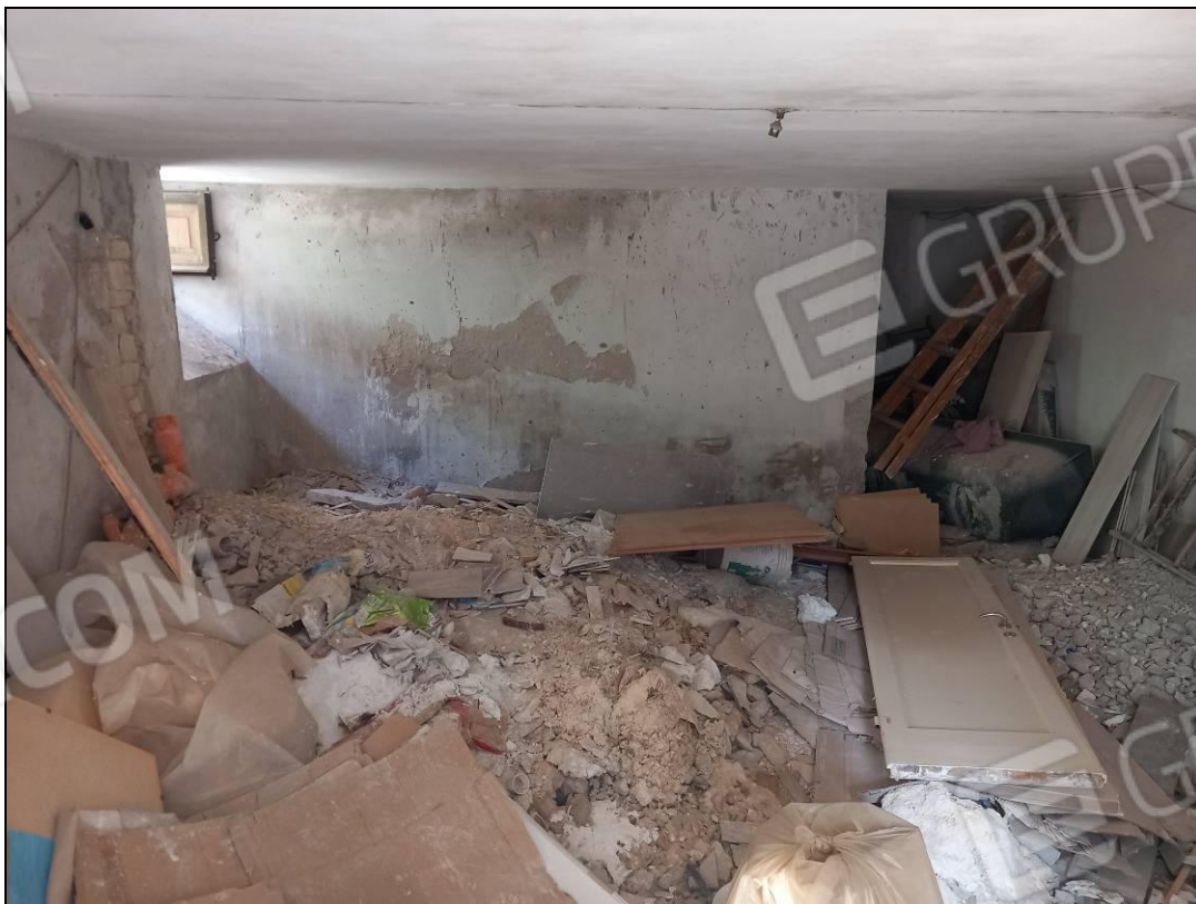
Foto 4: Vista dell'interno del locale
