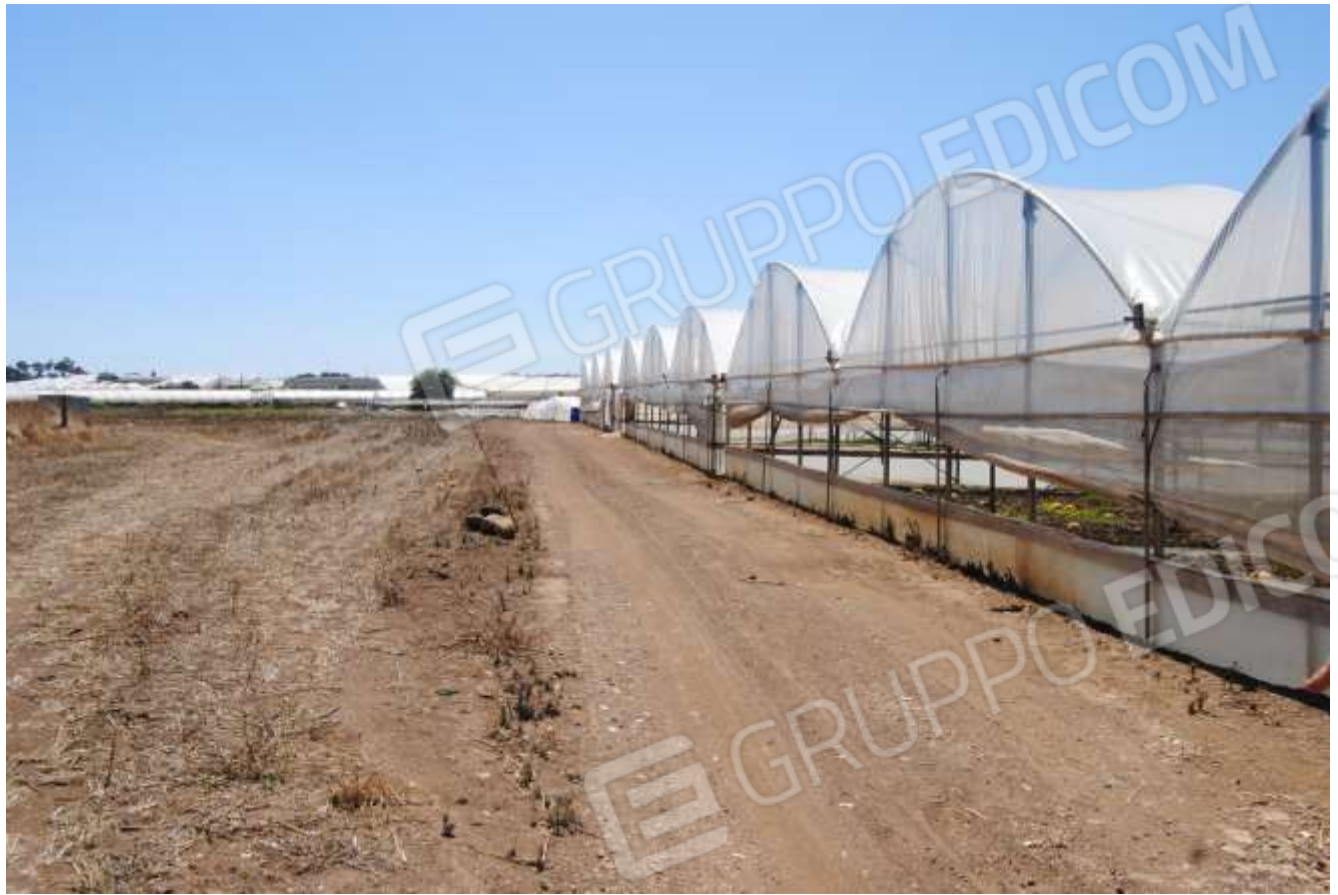
Foto n.4: Vista generale fondo agricolo/Fabbricatofondo agricolo.
