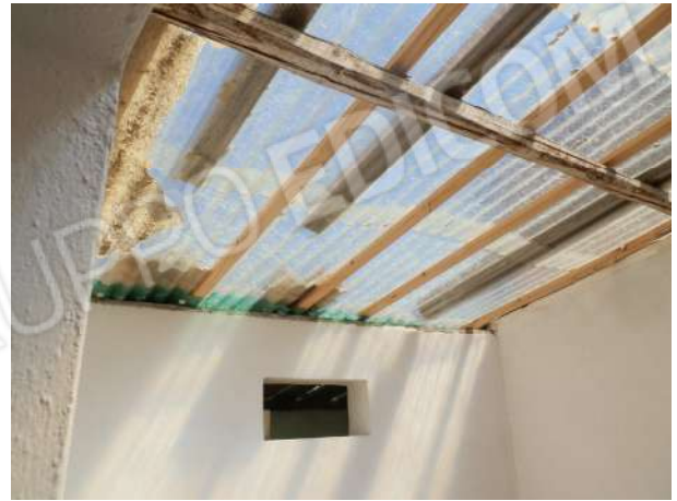
COPERTURA VANO SCALA
