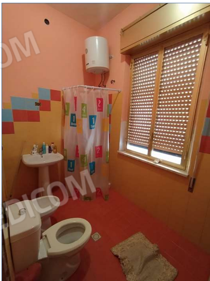
Fot. 2: piano terra, bagno
