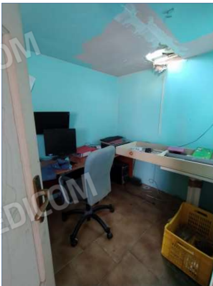
Fot. 8: piano terzo, vano ripostiglio
