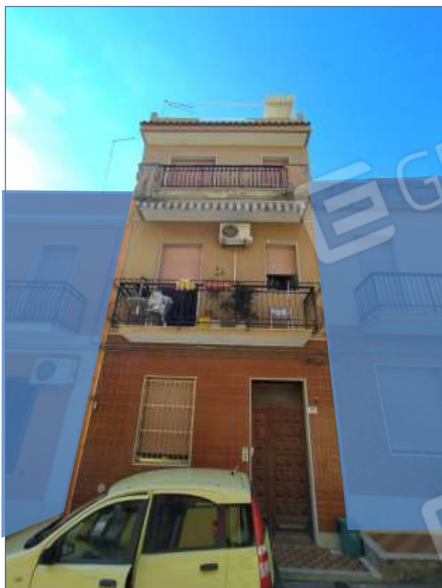
Fot. 13: prospetto su Via Sempione, vista frontale
