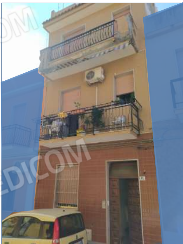
Fot. 12: prospetto su Via Sempione, vista da nord-ovest
