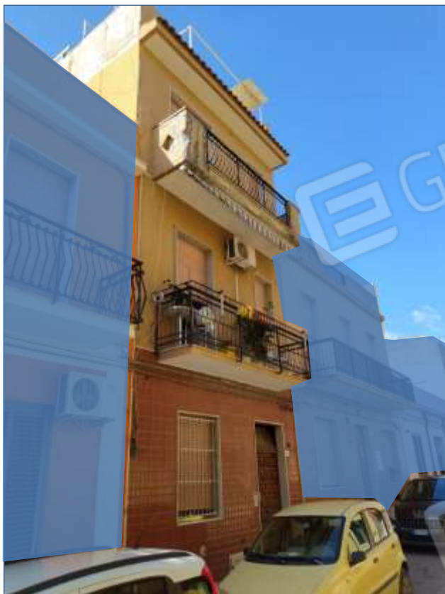
Fot. 11: prospetto su Via Sempione, vista da nord-est
