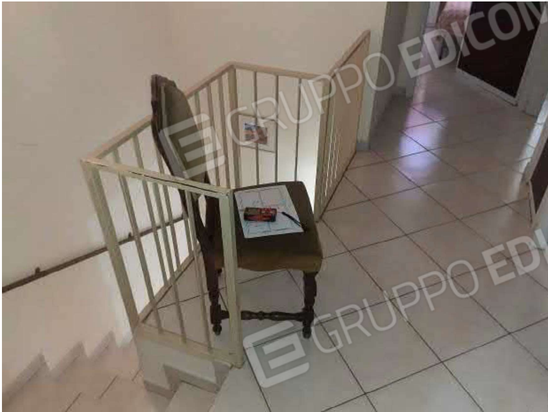
FOTO N. 13 – DISIMPEGNO PIANO SECONDO
