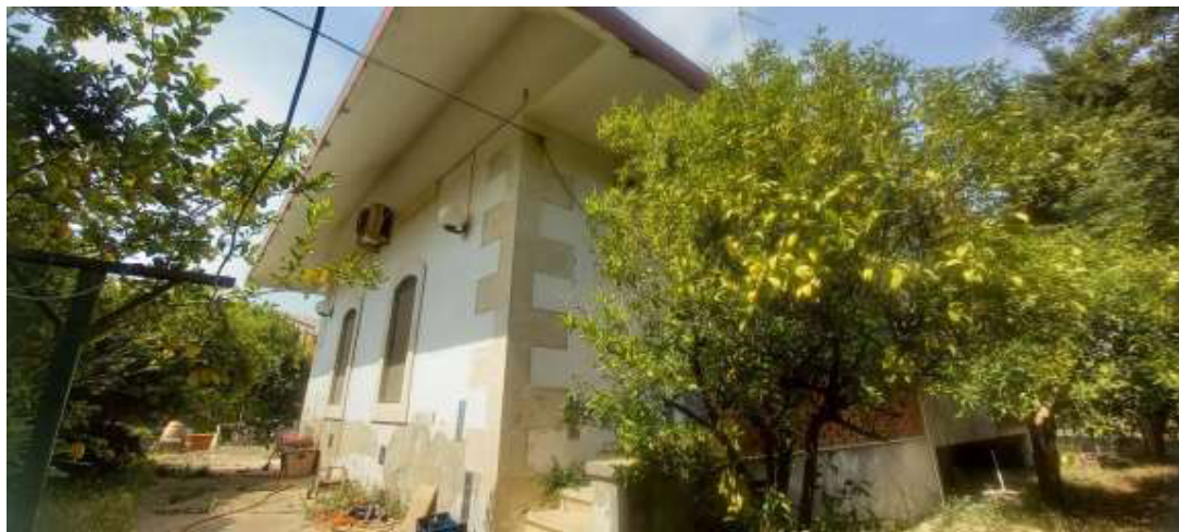
Foto 8 – Immobile “1A” – Prospetto Est
