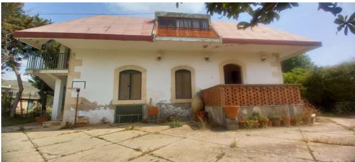
Foto 6 – Immobile “1A” – Prospetto principale del fabbricato a Sud
