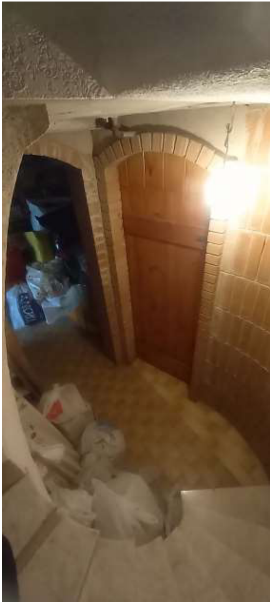
Foto 29 – Immobile “1A” – Piano seminterrato
