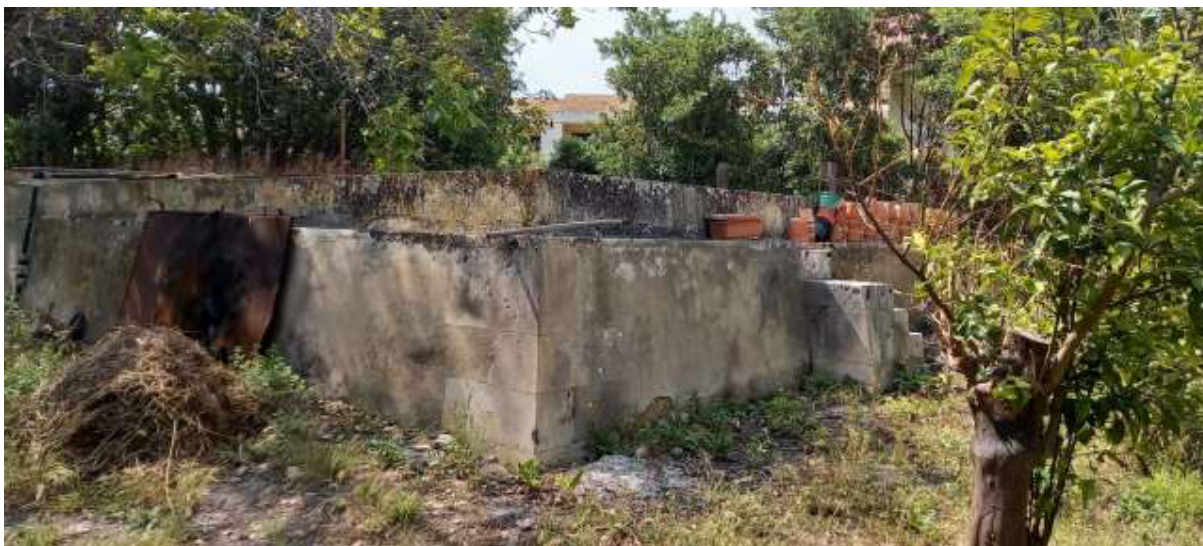
Foto 15 – Immobile “1A” – Cisterna raccolta acque, di forma quadrangolare
