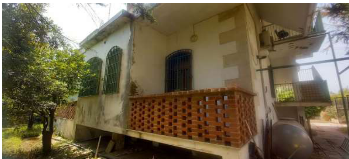
Foto 10 – Immobile “1A” – Prospetto Nord
