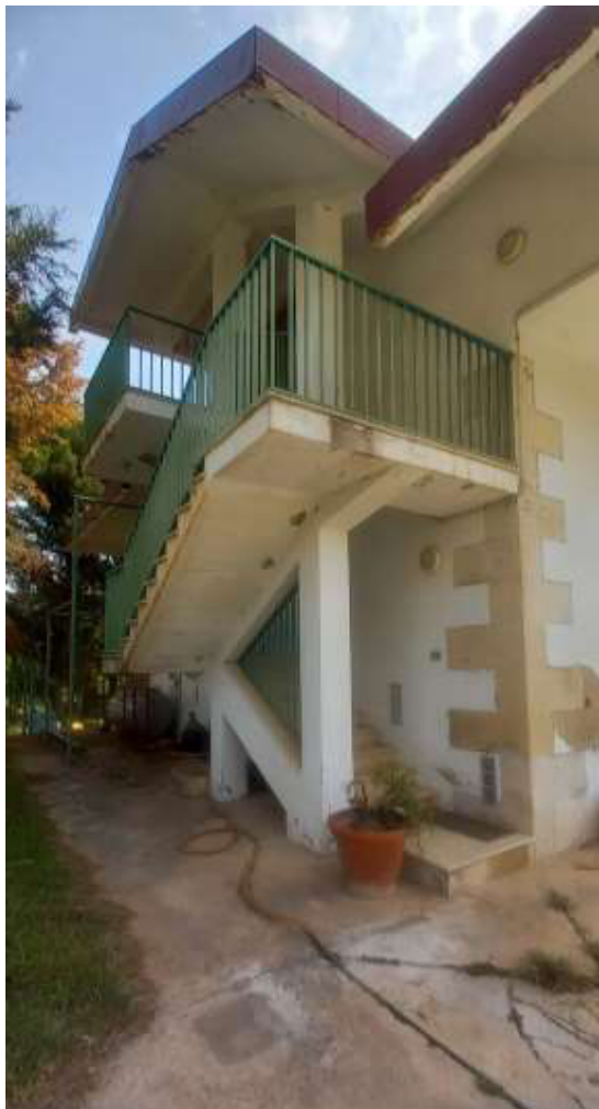
Foto 11 – Immobile “1A” – Prospetto Ovest
