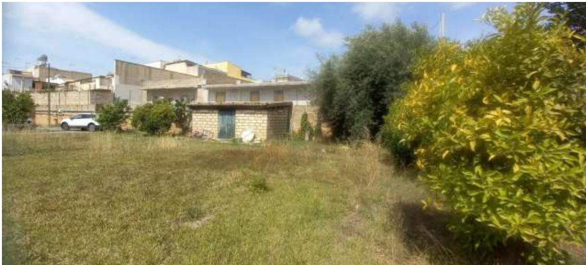
Foto 14 – Immobile “1A” – Locale “deposito”
