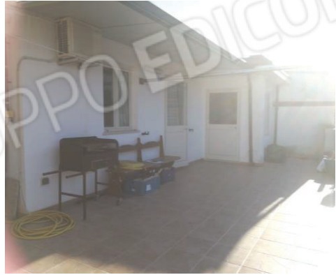
foto 46 – piano copertura vano 1
