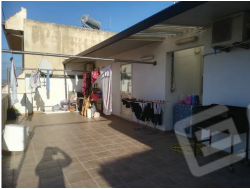
foto 45 – piano copertura vano 2
