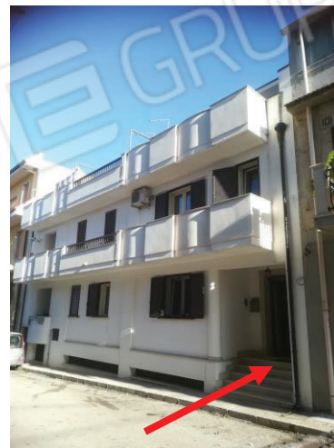
foto 2 – accesso edificio via Cile n. 25
