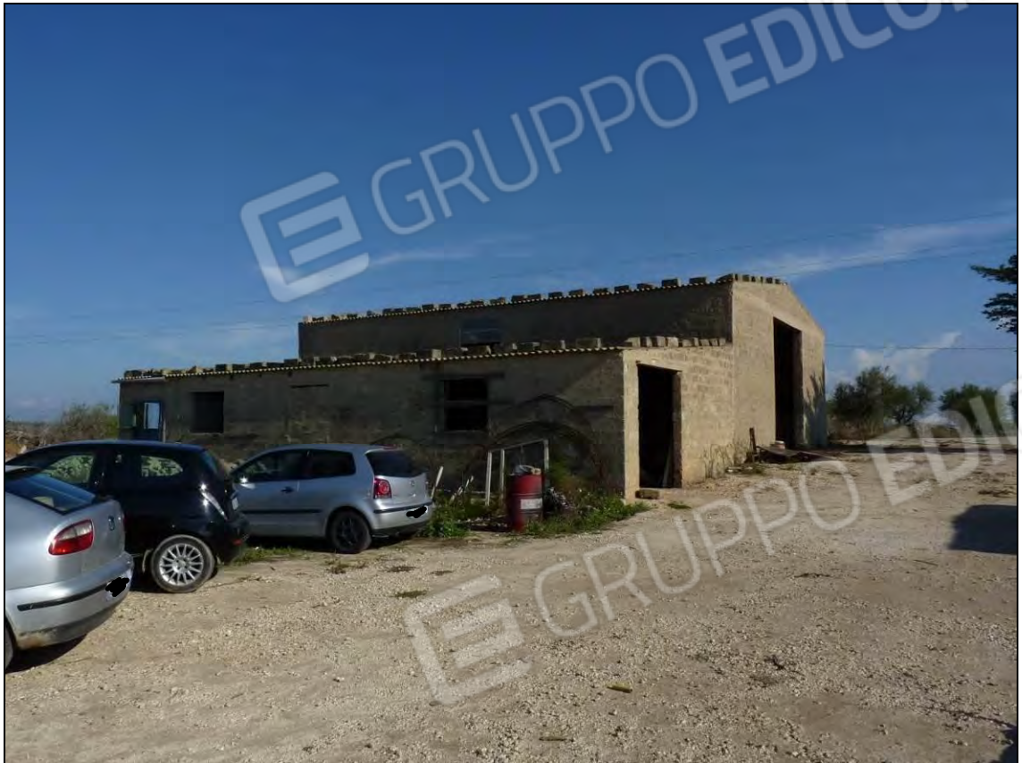
FABBRICATI RICADENTI IN PARTE NELLA PARTICELLA 936 ED IN PARTE NELLA P.LLA 935, NON OGGETTO DI PIGNORAMENTO - FOTO 87
