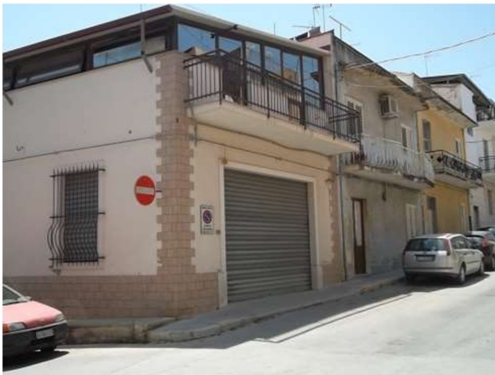
Foto 19 – Immobile “2A” – Prospetto su via Delle Cave
