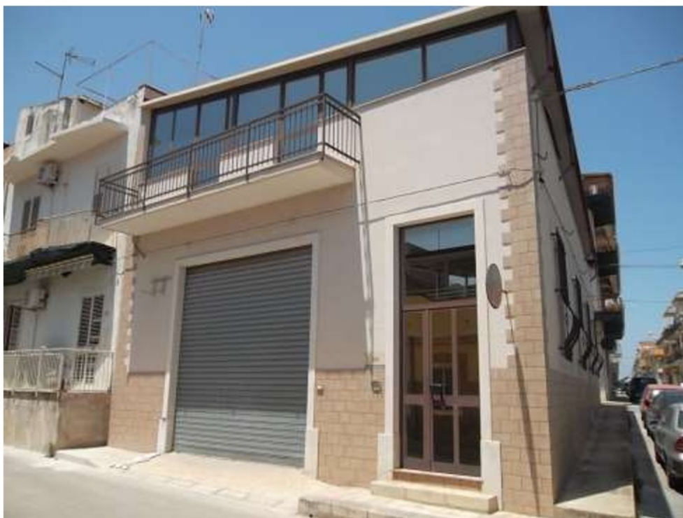
Foto 17 – Immobile “2A” – Prospetto su via Manzoni
