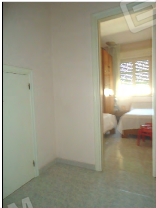
Foto n.15 – Porta ripostiglio sottoscala
