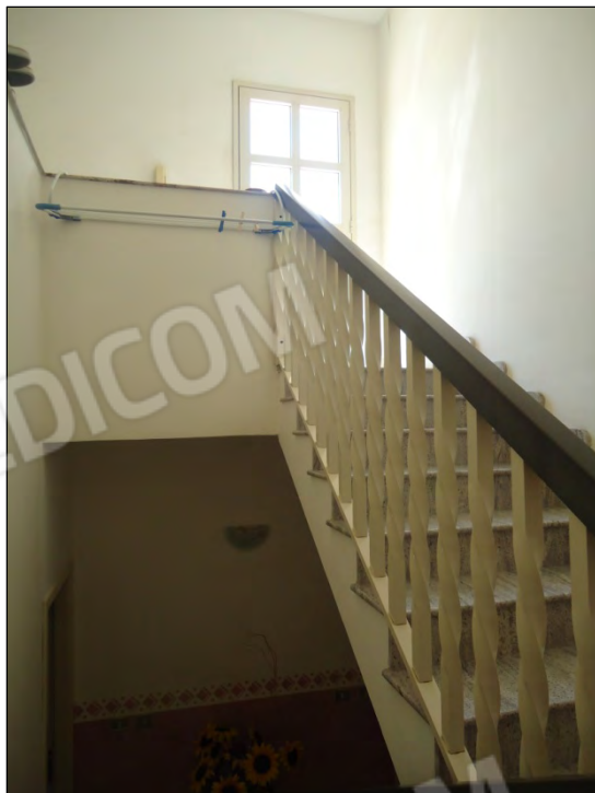
Foto n. 8 – Arrivo al lastrico solare
