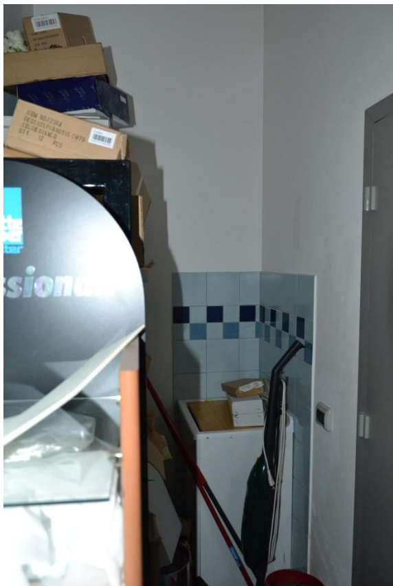
Fot. 17: piano primo, servizi igienici
