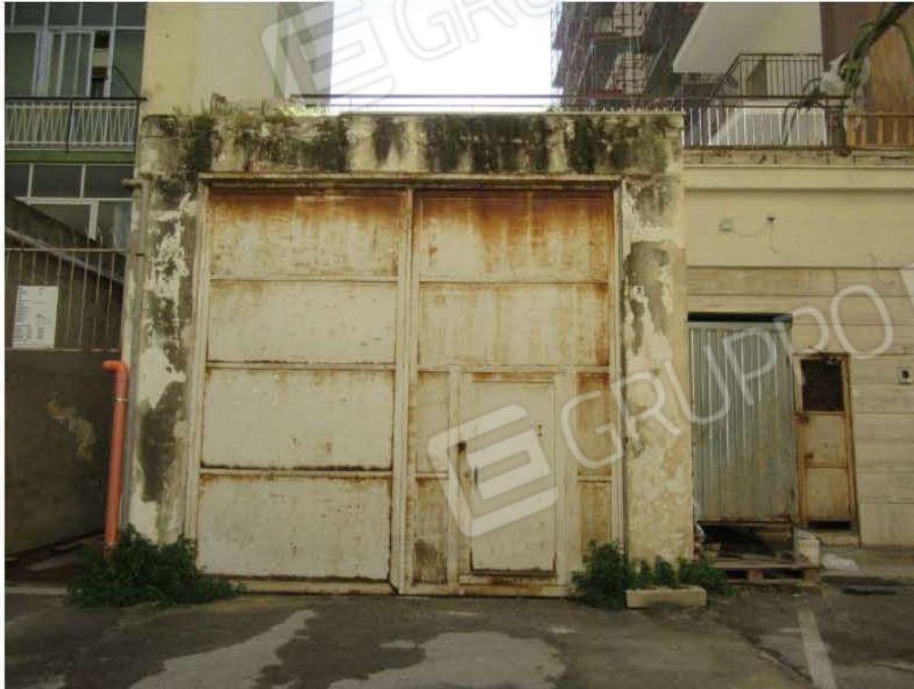
Foto 1_ Prospetto immobile su cortile condominiale
