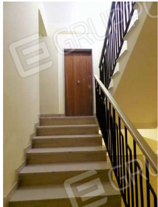
Foto n° 2.4. Palazzina "R": Vano scala
