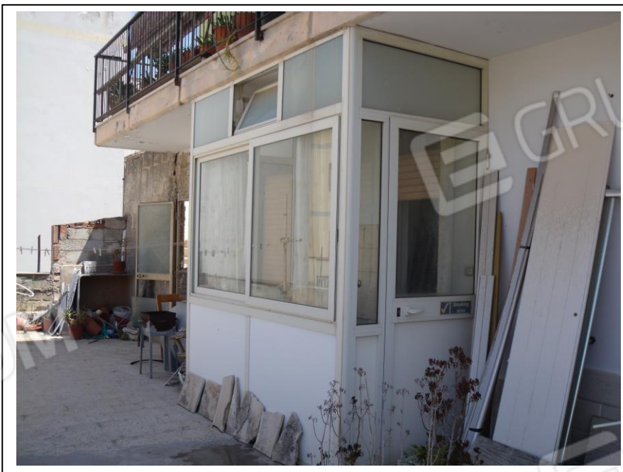
10. Terrazzo comune al piano 2, presenza di veranda abusiva di proprietà dei debitori in causa.
