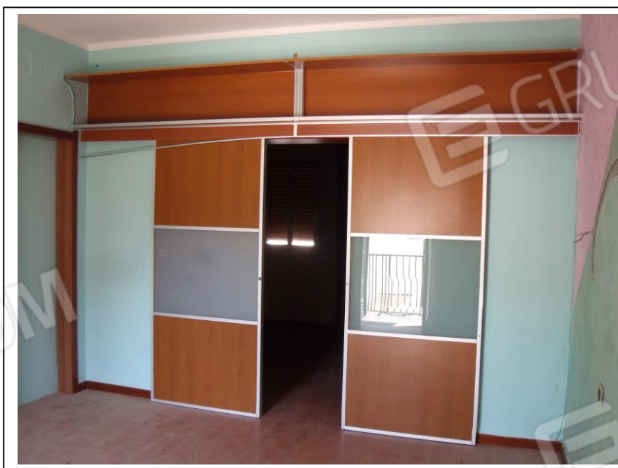
27. Interno u. i. con vista verso lato nord, in foto porta scorrevole a due ante di separazione con vano adiacente. Sulla sinistra presenza di vano porta preesistente chiuso successivamente.
