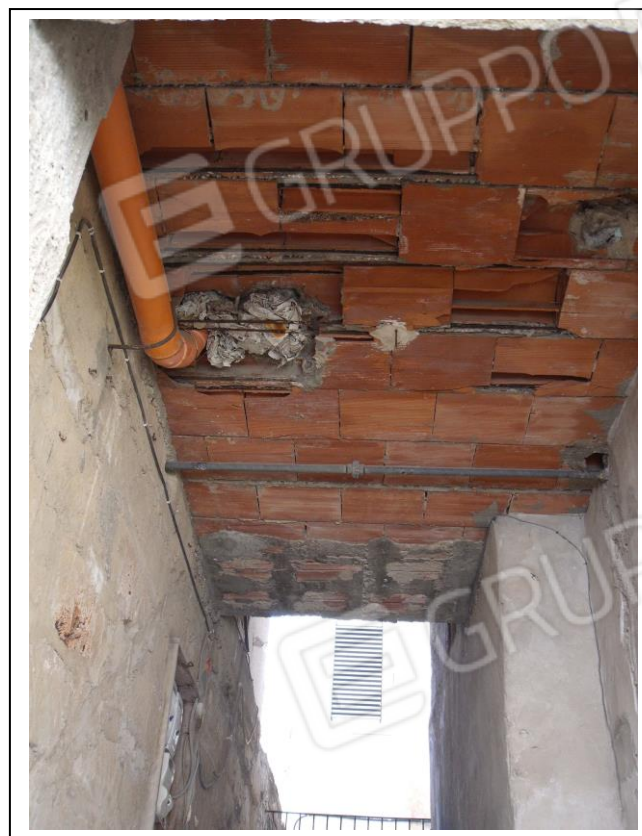
08. Ingresso dal numero civico 10, solaio di copertura in pessime condizioni di manutenzione.
