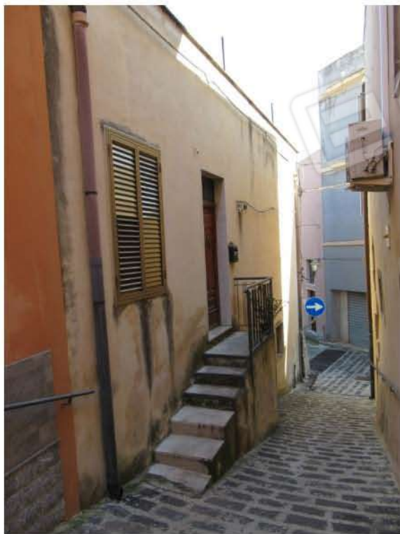
Foto 1_ Prospetto su Via Tranchina
