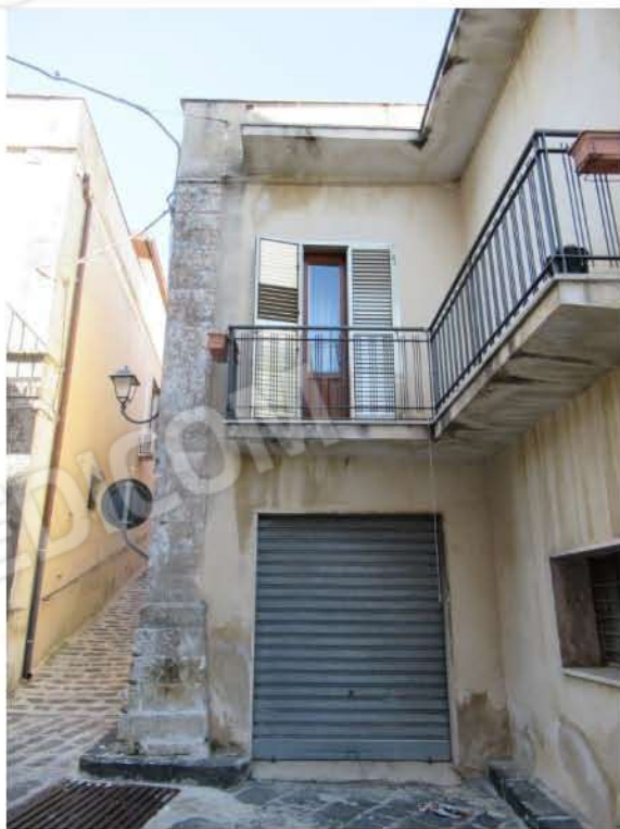
Foto 3_ Prospetto su Via Vittorio Emanuele
