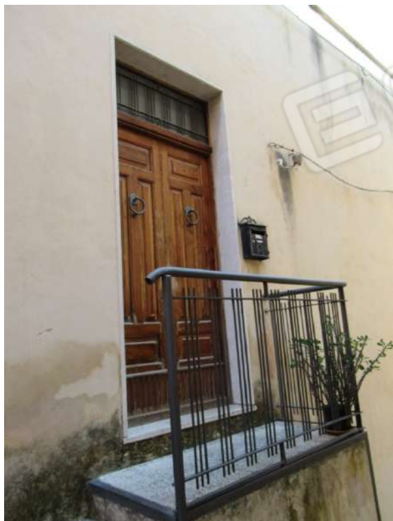
Foto 1_ Accesso da Via Tranchina
