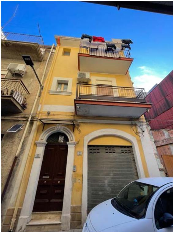
Vista esterna del fabbricato
