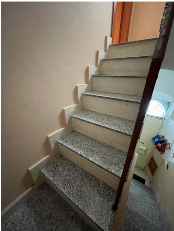
Vista del vano scala
