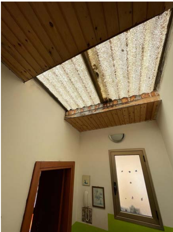
Vista del vano scala al secondo livello
