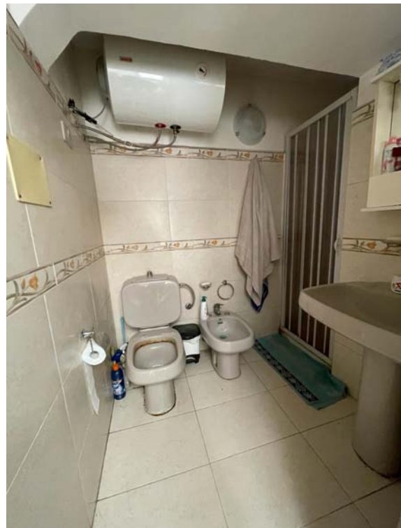
Vista del servizio igienico
