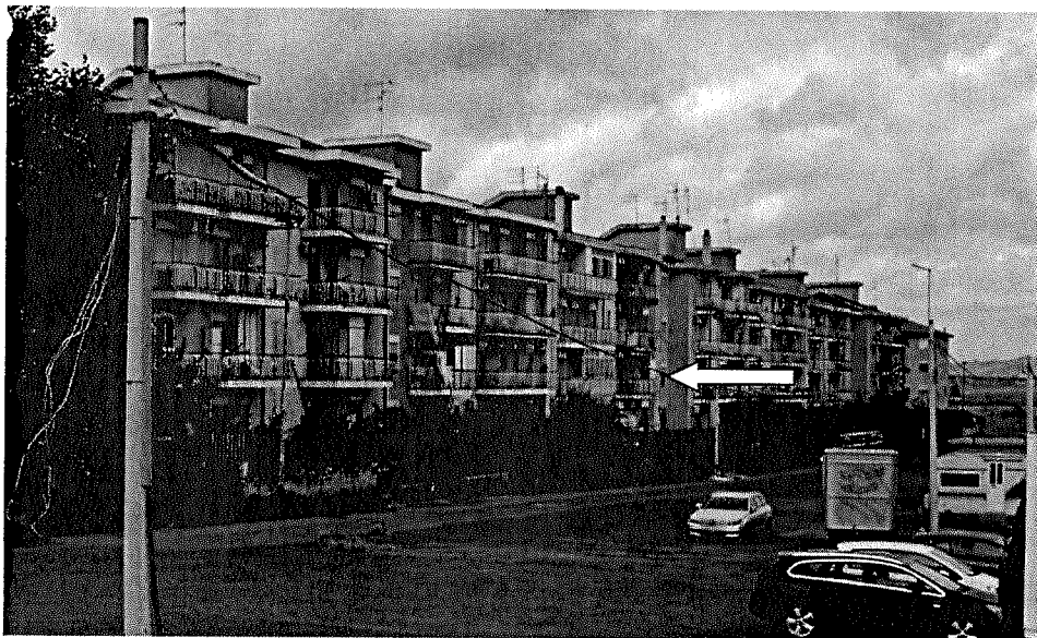
Prospetto nord del complesso condominiale con indicazione dell'appartamento pignorato - immagine tratta da Google Earth
