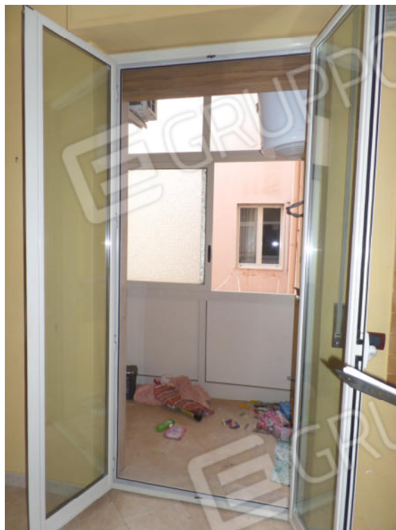
Foto n° 7. Piano 2°: Balcone Cucina
