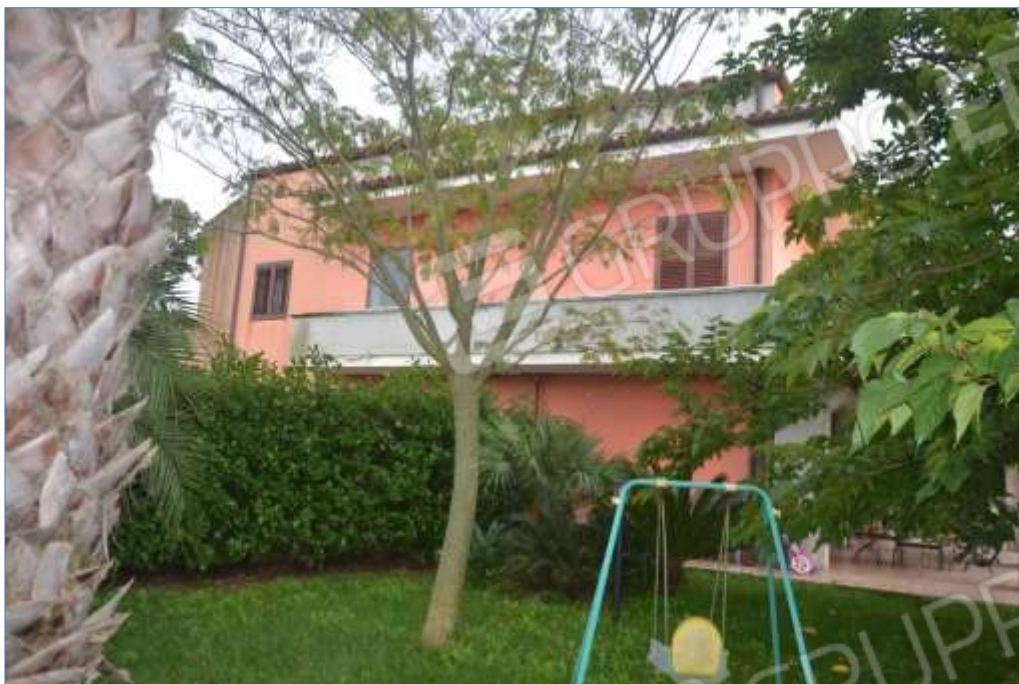
Fot. 17 Vista generale, prospetto nord
