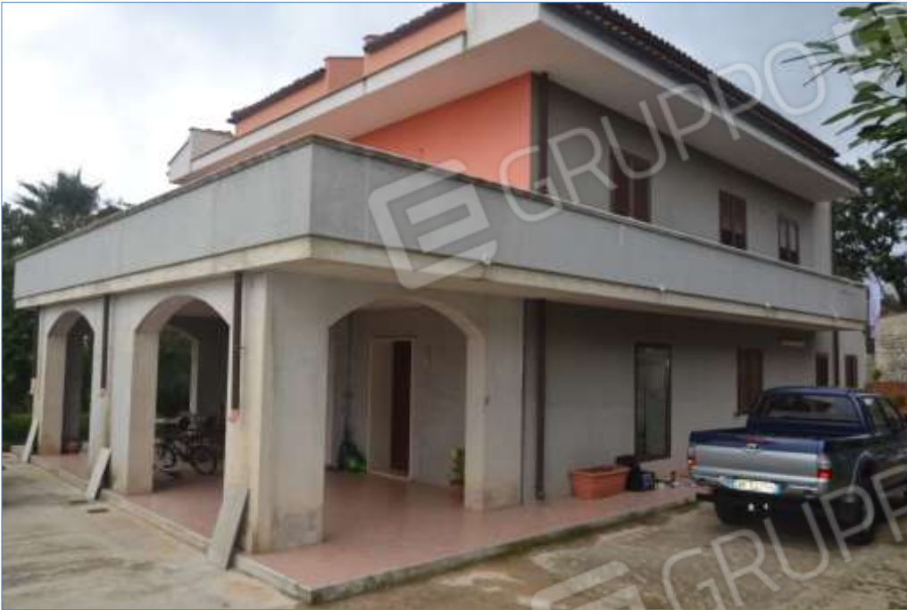
Fot. 1 Piano terra, prospetto ovest: veranda-portico da cui si accede all'unità immobiliare, vista da sud-ovest
