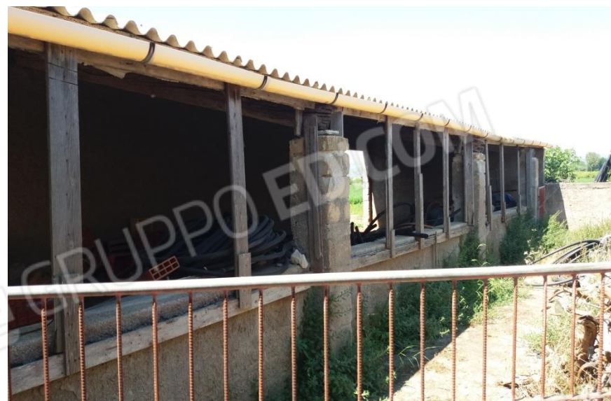
Foto 8 – Prospetto su cortile
