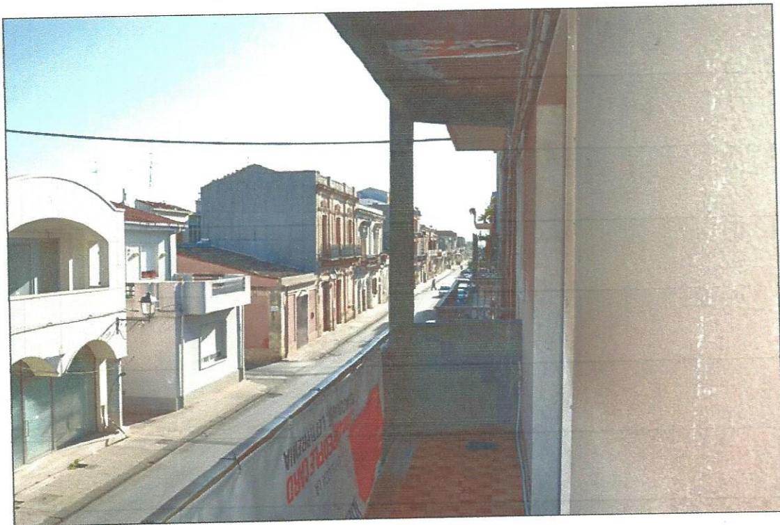
Fot.n°10: piano primo, balcone esterno su Via Vittorio Emanuele.
