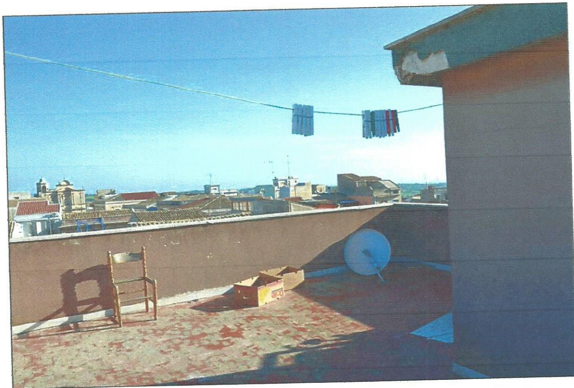
Fot.n°16: piano terzo, terrazza di copertura.
