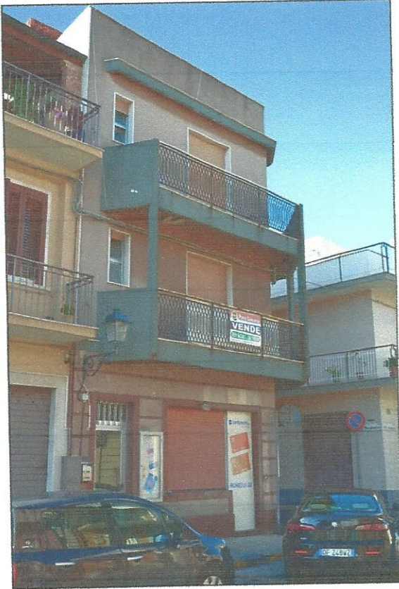
Fot.n°3: vista generale dell'immobile dalla Via Vittorio Emanuele
