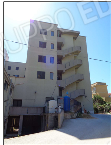
15_Prospetto sul retro_A
