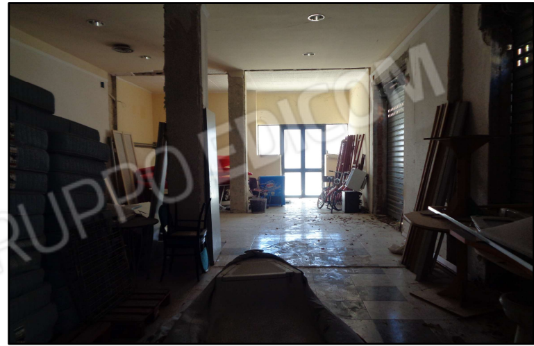
37_Vano al PT fronte principale
