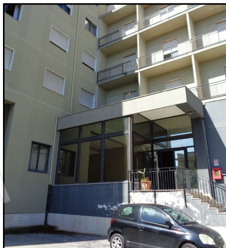
17_Ingresso laterale_corpo B
