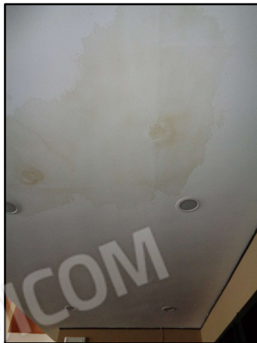
34_Particolari_infiltrazioni dal lastrico solare
