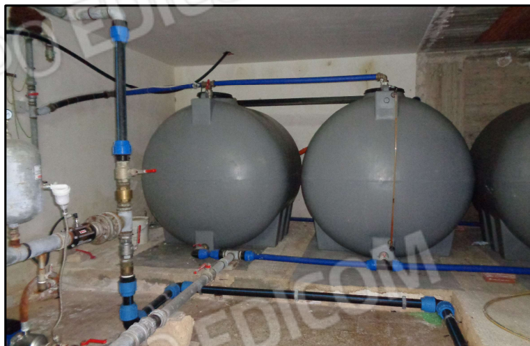
26_Impianto idrico_serbatoi
