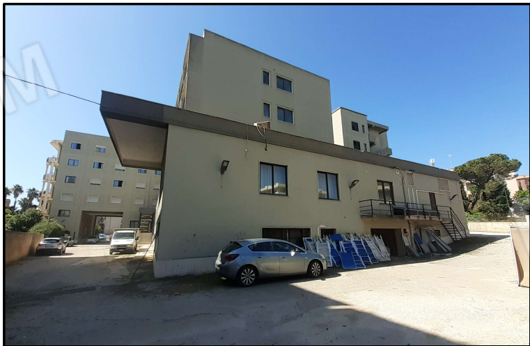
11_Prospetto sul retro_corpo B
