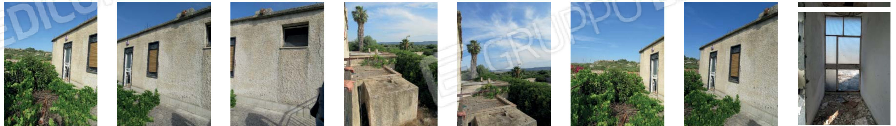
Foto da 127 a 132 - facciata immobile a sud-est
