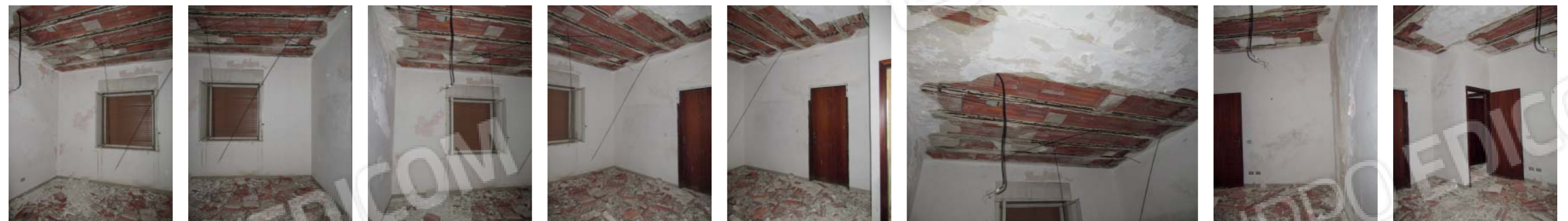
Foto da 141 a 148 , vano A7
