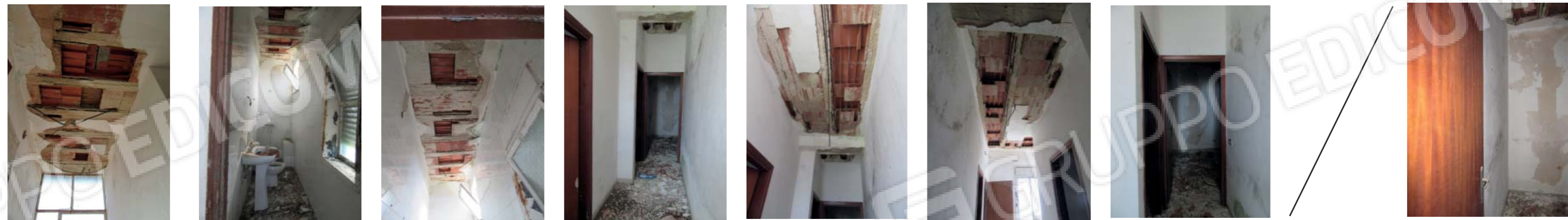
Foto 134 vano A1, Foto 135-136 vano A2
