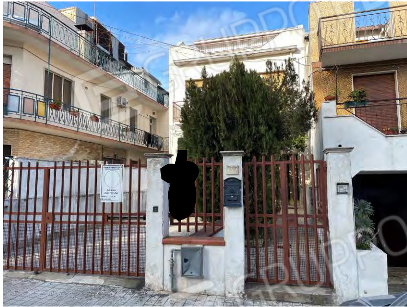
FOTO 1 – prospetto su Via Vittorio Emanuele III
