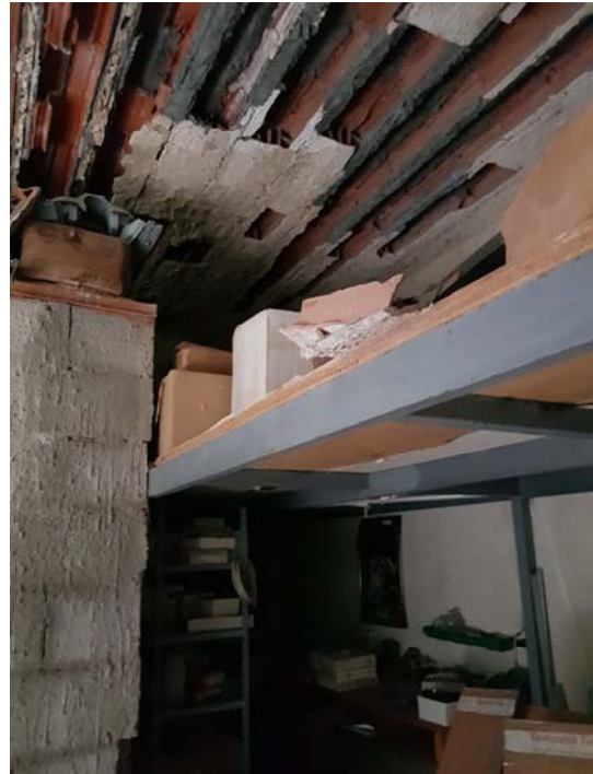
Vista del solaio del deposito (D1)
