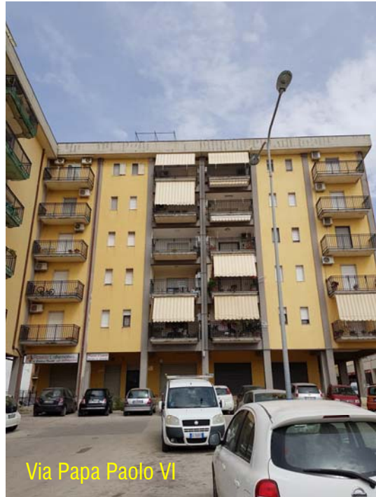
Vista dell'edificio su Via Papa Paolo VI
