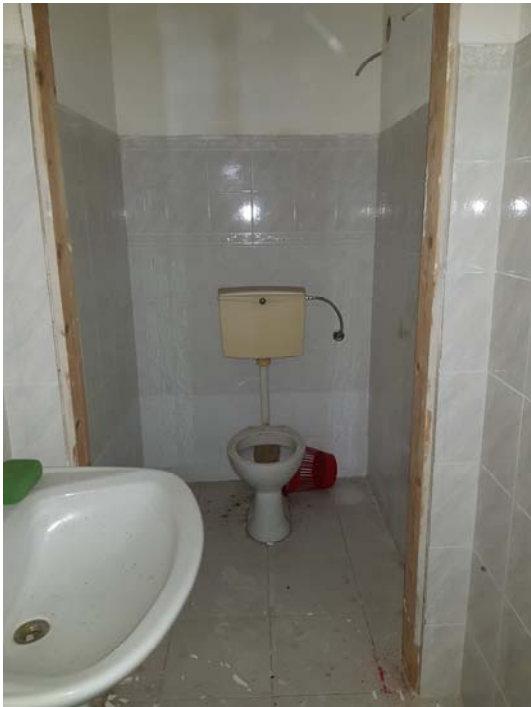
Vista dell'antibagno e del bagno (aWc e W)
