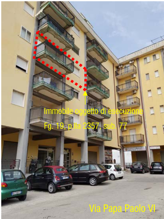
Vista dell'edificio su Via Papa Paolo VI
