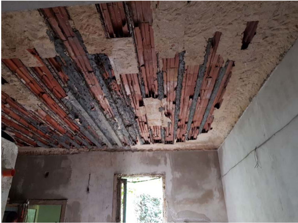
Vista del solaio del deposito (D1)
