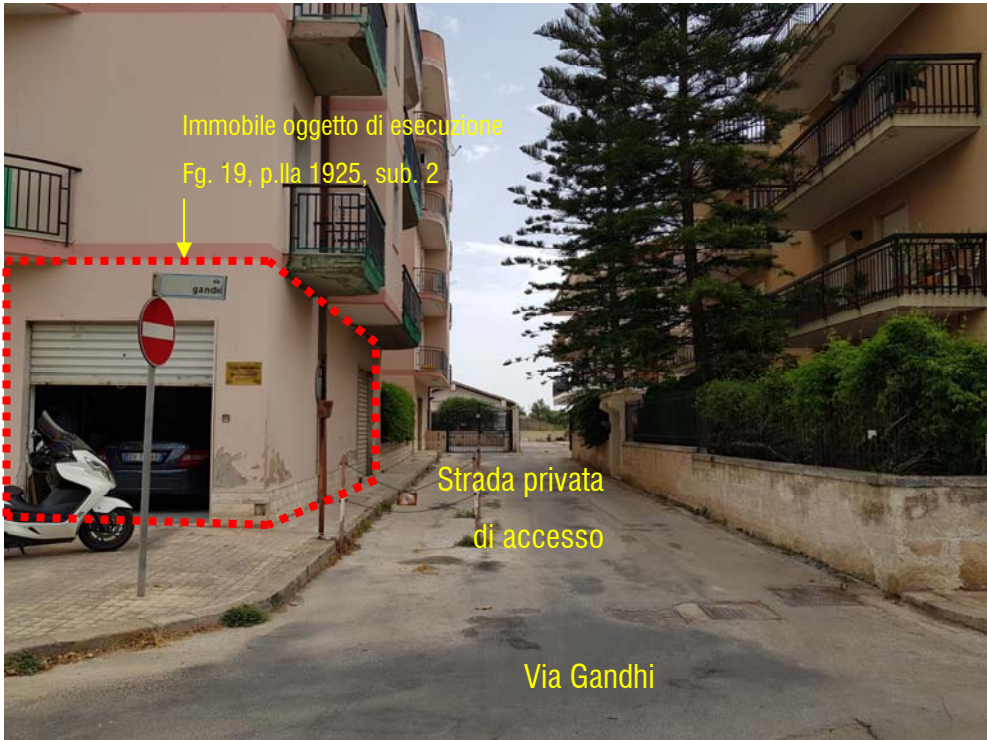
Vista della strada privata di accesso all'edificio su Via Gandhi (unità più grande)
