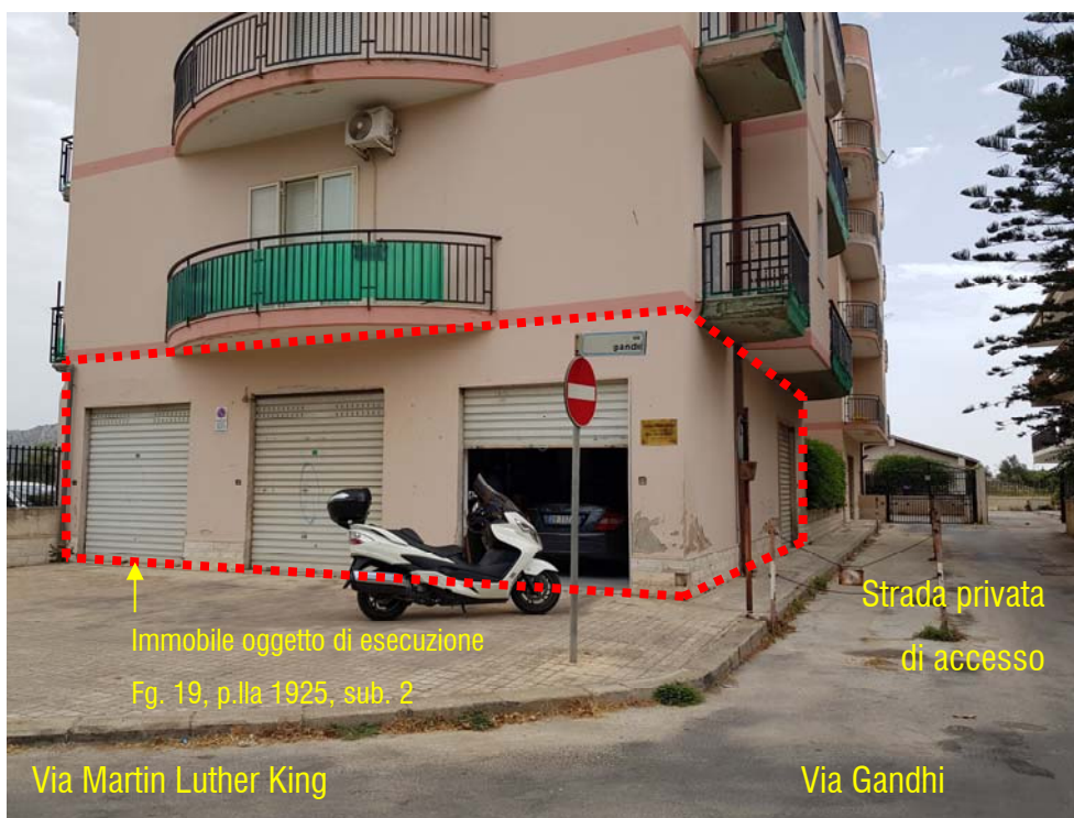
Vista dell'edificio su Via Martin Luther King angolo Via Gandhi (unità più grande)
