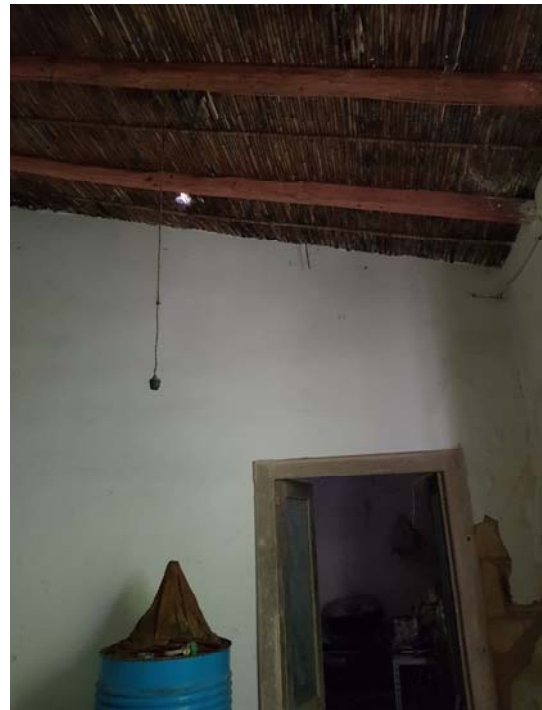
Vista della copertura del deposito (D2)
