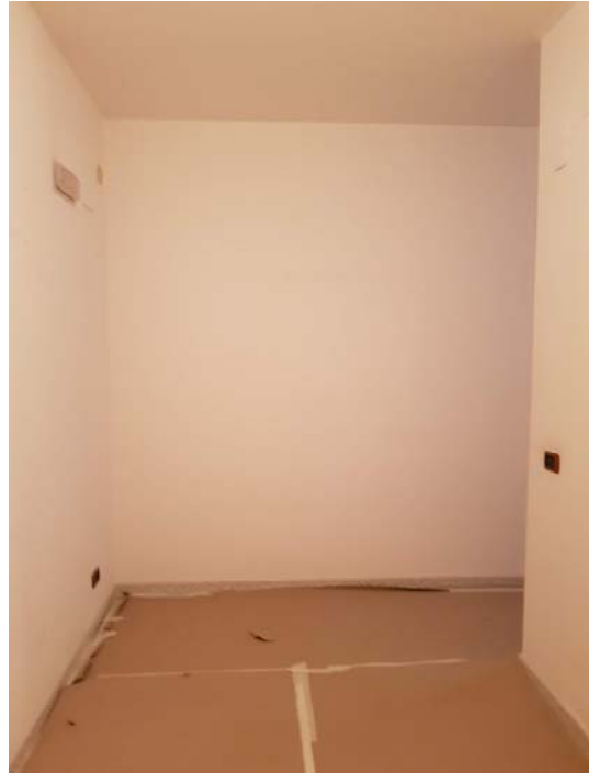
Vista dell'ingresso (I)
