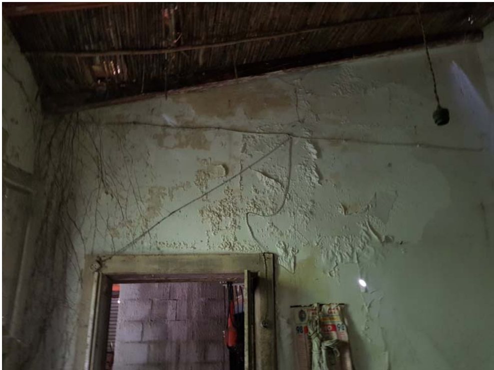
Vista del solaio del deposito (D2)
