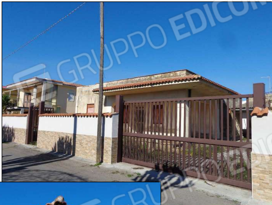
Prospetto dalla strada con cancelli d'ingresso.
