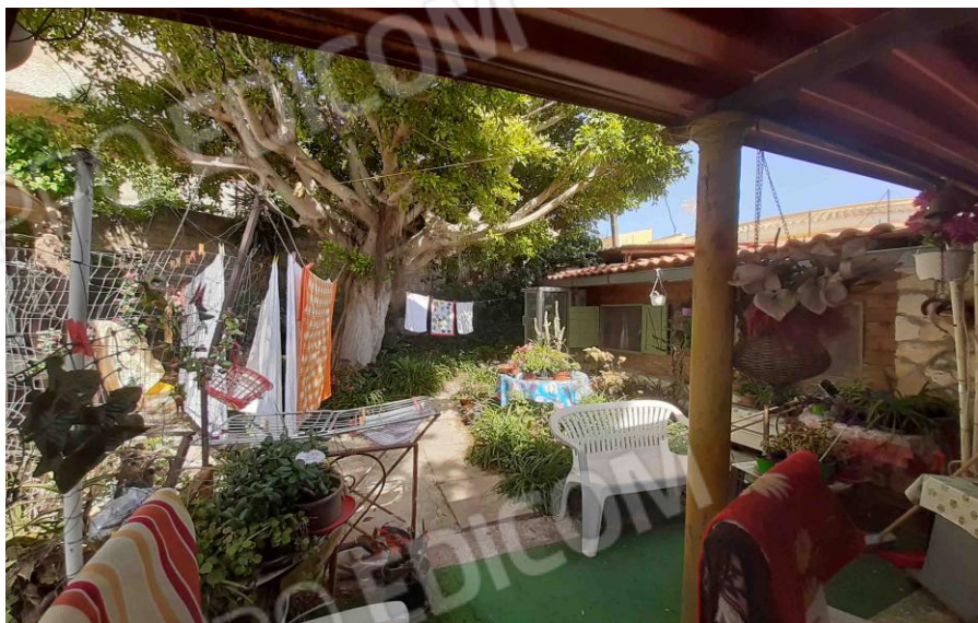
Foto 12 – Tettoia antistante il fabbricato
