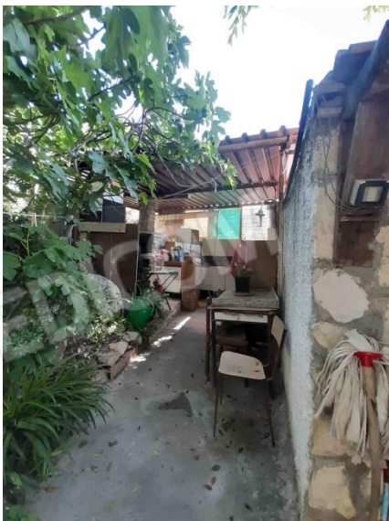
Foto 14 – Tettoia adiacente al Fabbricato
