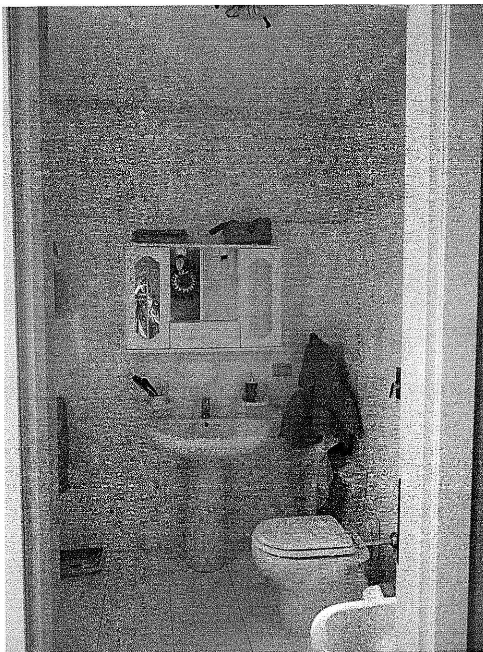
Foto 7 – Fabbricato “1A” – Piano I - Bagno
