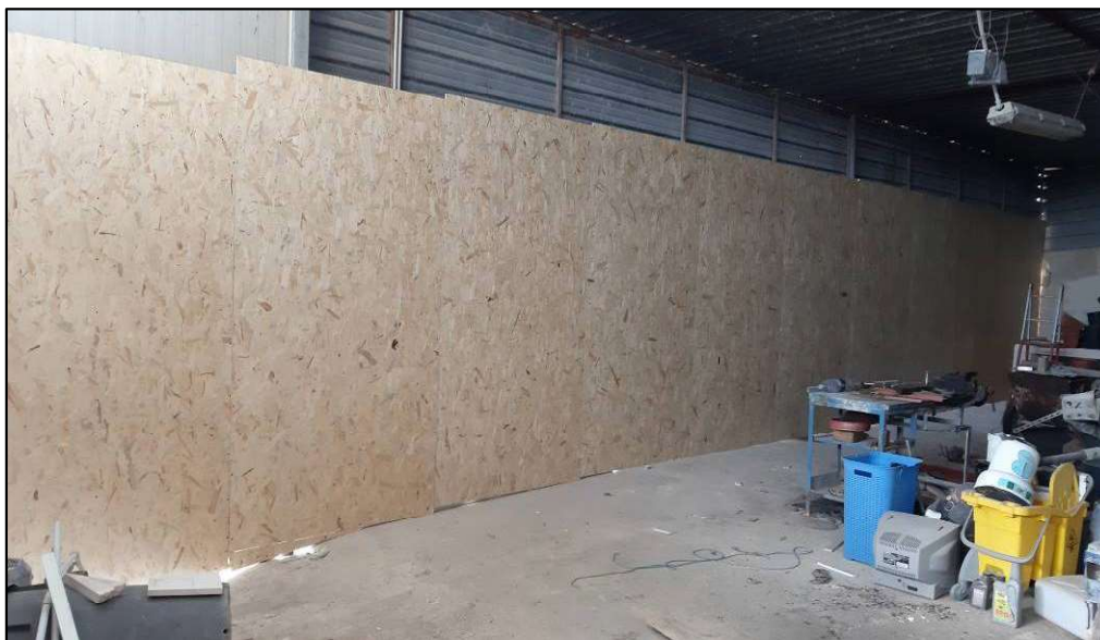
Foto 5 _Immobile oggetto di stima_Interno
