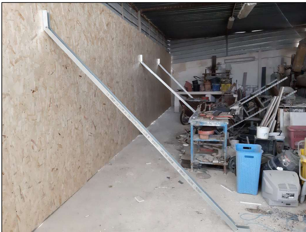
Foto 7 _Immobile oggetto di stima_Interno_Opere ultimate (con posa di puntelli)
