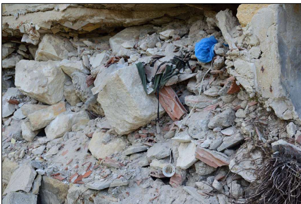
Foto 4 _Materiale costituente il riempimento
